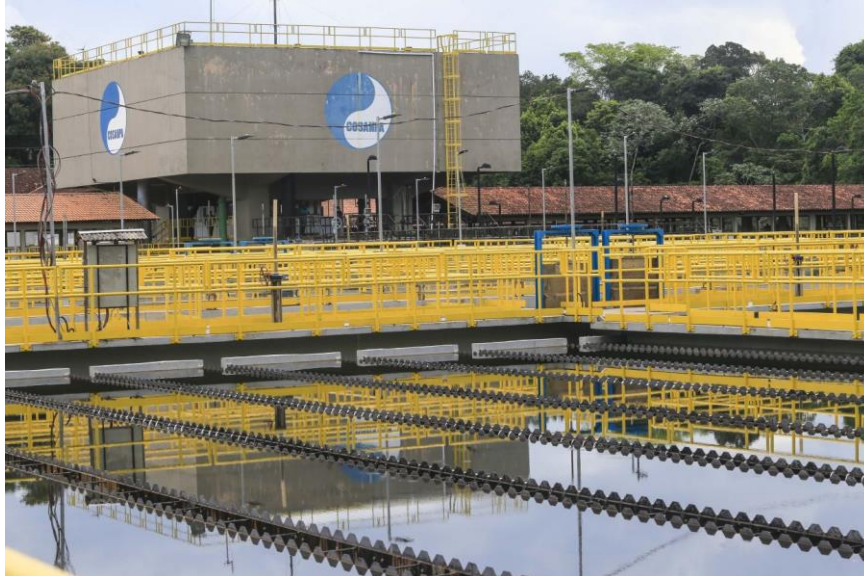
Figura 5- Reservatório de abastecimento de água na concessionária do estado (COSANPA)
