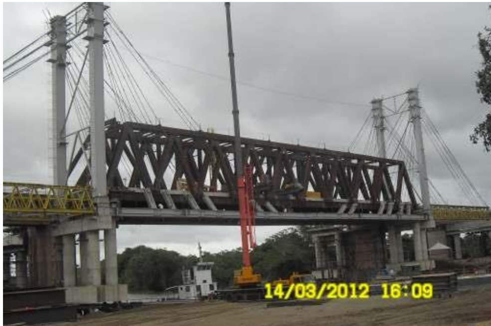
Figura 3: Instalação dos pilones estaiados para substituição do vão metálico
