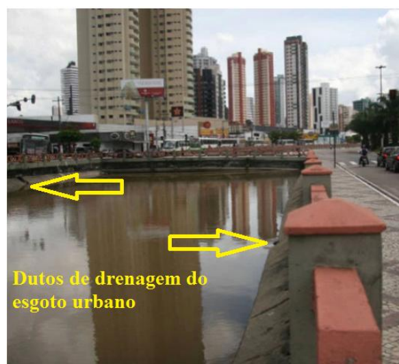
Figura 2. Canal retificado da Avenida Doca de Souza Franco, região central de Belém, com a ilustração da interação entre a drenagem de esgoto urbano e a água estuarina.
