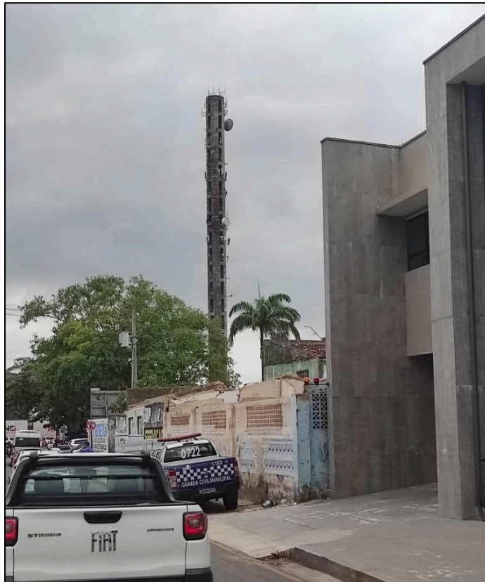
Figura 12 – Torre de concreto
