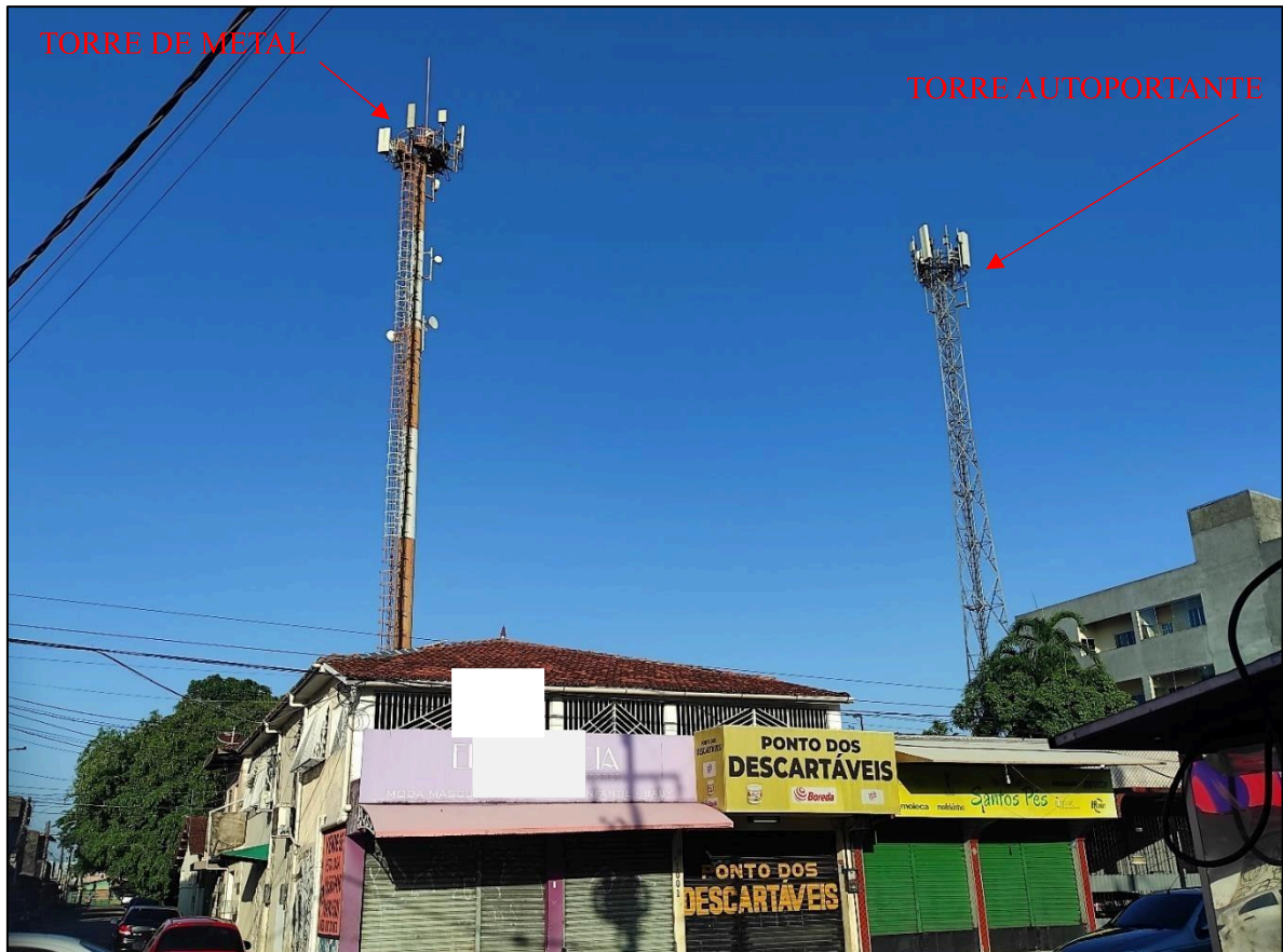
Figura 10 – Torre de metal e torre autoportante
