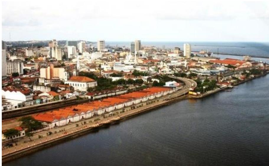
Figura 6: Galpões antes de serem parcialmente demolidos.
