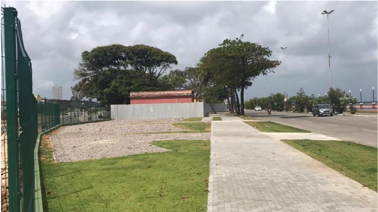
Figura 11: Início dos serviços preliminares dos empreendimentos Mirante do Cais e Parque do Cais.
