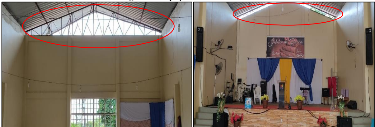
Figura 32. Espaço entre as estruturas
