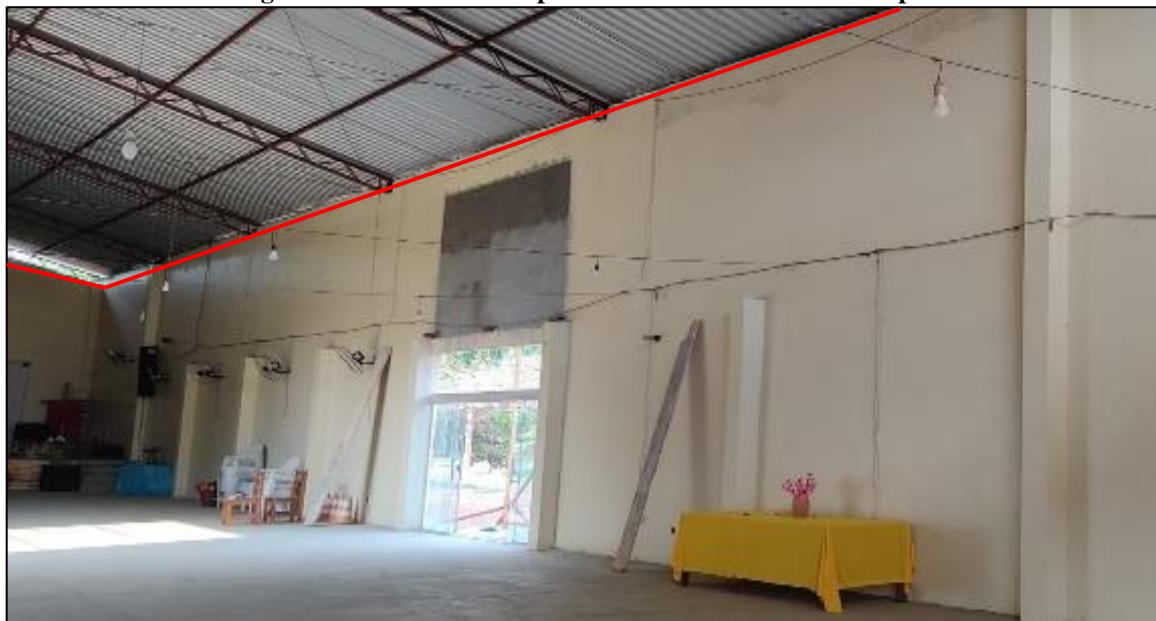
Figura 30. Estruturas de apoio ao telhado em volta do templo
