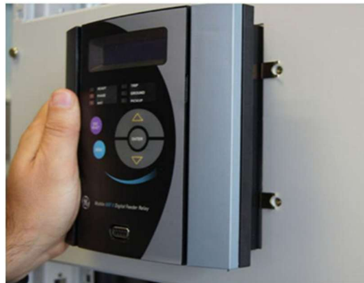
Figura 24 - Retirando o relé.
