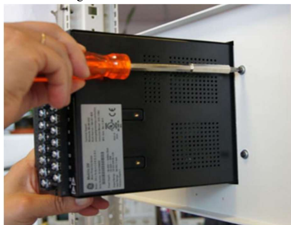
Figura 27 - fixando o novo relé.
