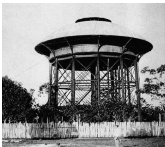
Figura 17 - Reservatório de ferro de São Brás (1898)
