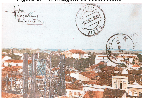
Figura 57 - Montagem do reservatório
