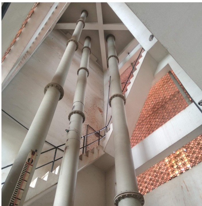
Figura 42 - Vista interna do reservatório moderno
