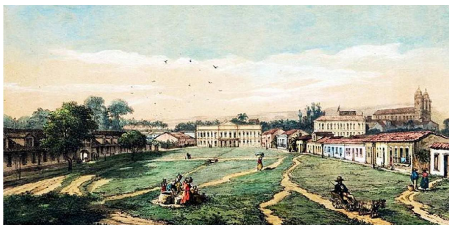
Figura 13 - Poço público no Largo Quartel General
