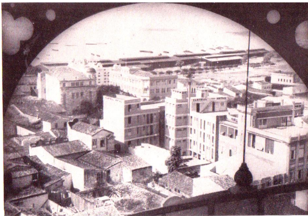
Figura 96 - Vista da cidade tomada do reservatório
