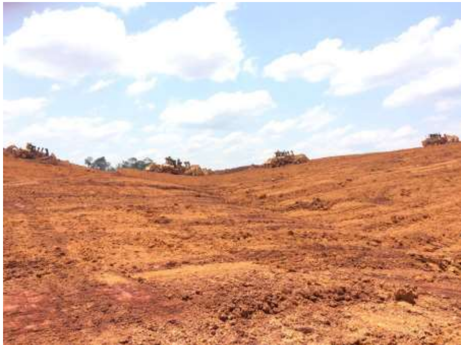
Figura 5.3 – Tratores realizando a atividade de decapeamento da camada de argila.
