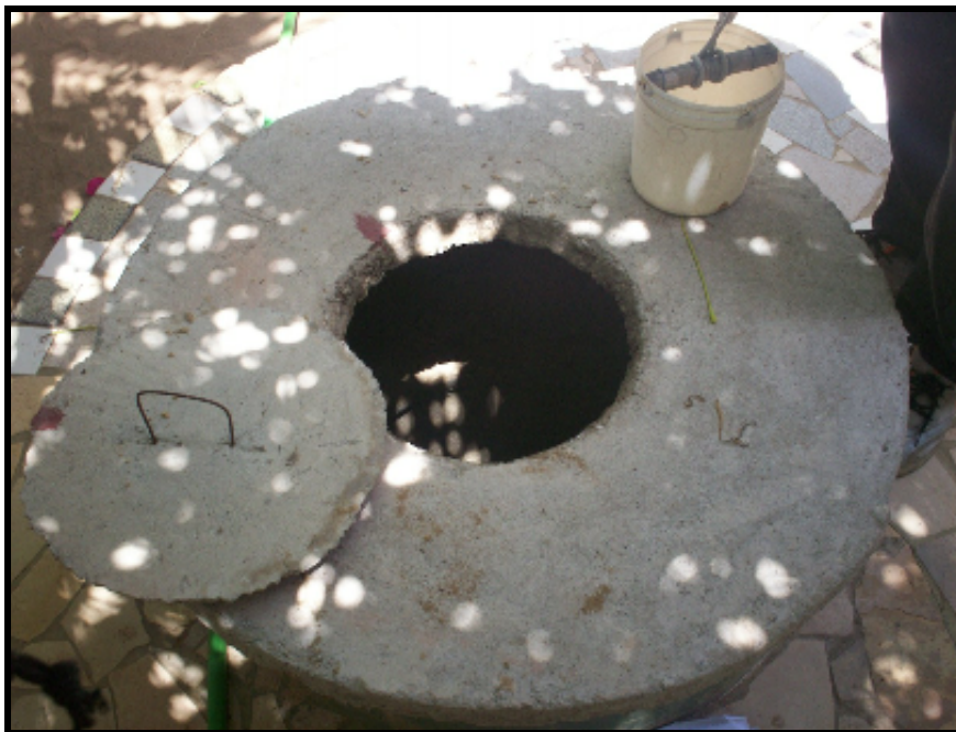
Foto 04 – Poço manual (PM) localizado no bairro Vicente Pizon, Fortaleza/CE. (Novembro/2007)
