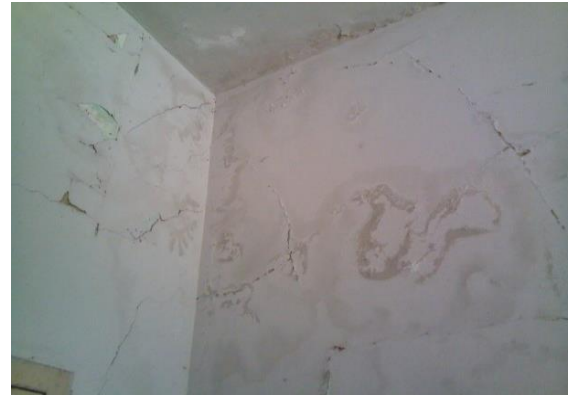
Fotografia 18- Paredes com infiltrações e mofadas
