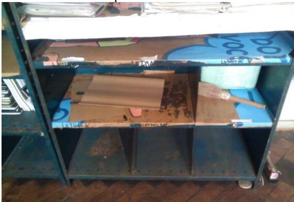
Fotografia 13 - Estado de conservação dos armários e o nível de arrumação dos documentos do arquivo do CAEE
