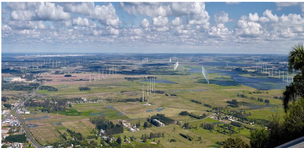
Figura 33: Complexo Eólico de Osório- RS.
