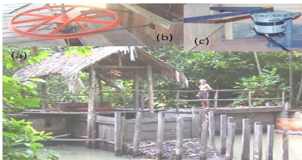
Figura 37: (a) Estrutura onde foi instalada a turbina. (b) Polia conectada à turbina. (c) Alternador conectado à polia, utilizado como gerador. Fonte: Fleming, (2012).
