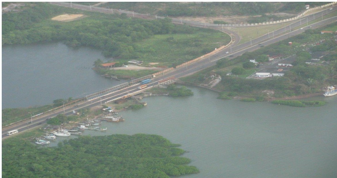
Figura 35: Vista aérea da barragem Bacanga -MA. Fonte: http://kamaleao.com/saoluis/1287/barragem-do-bacanga .
