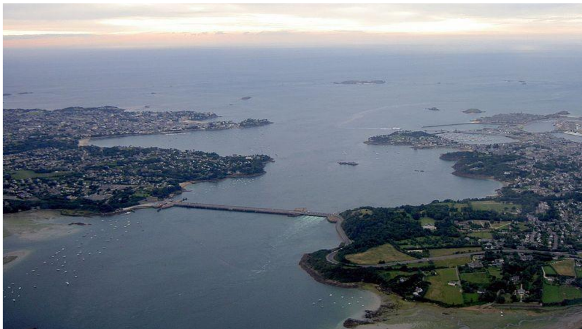
Figura 30: Vista aérea da usina de La Rance. Fonte: Sesmil (2013).
