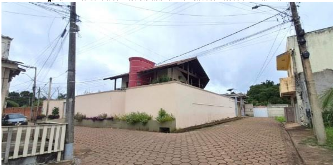
Figura 7 - Residência bem estruturada na Avenida João Pessoa em Altamira - PA
