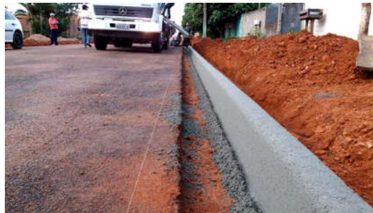
Figura 12. Serviço de execução in loco de sarjeta e meio fio.
