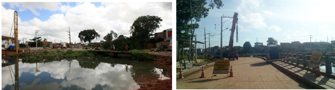
Figura 45. Evolução da construção da ponte da Rua dos Mundurucus, onde na primeira imagem em maio de 2018, a ponte era de madeira, já na segunda imagem realizada pelo autor no dia 08 de agosto de 2018, tem-se a construção da travessia em concreto.
