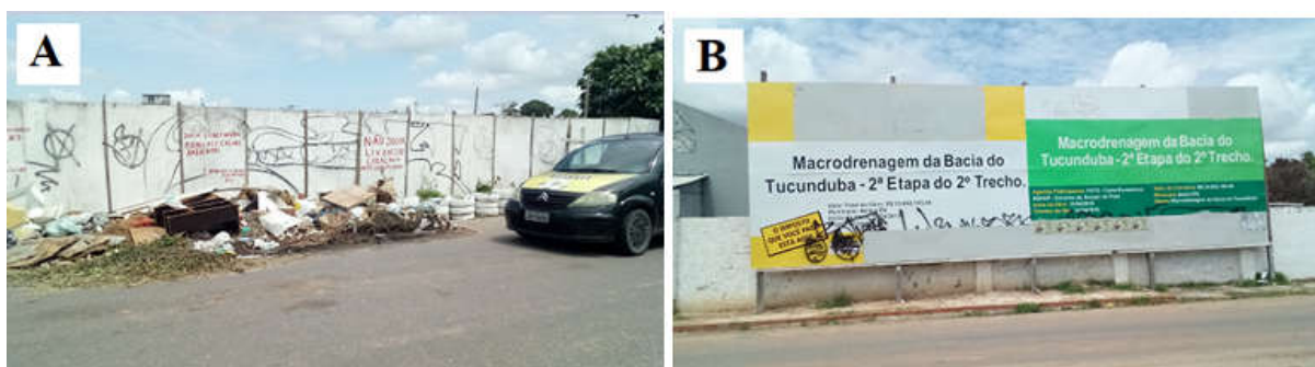
Figura 68. Fechamento com tapumes nas áreas não ocupadas da quadra (A) e placa indicando a segunda etapa das obras de macrodrenagem nas imediações da quadra do Curtume (B), foto tirada em 04 de agosto de 2019.
