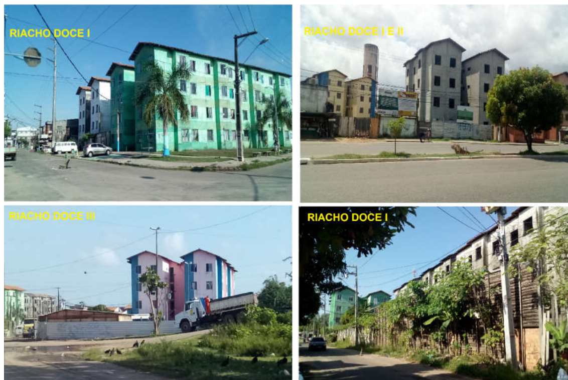
Figura 62. Condição Atual das edificações do Riacho Doce I, II e III.
