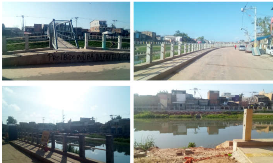
Figura 44. Vista do Rio no trecho entre a Rua Napoleão Laureano e a Rua dos Mundurucus, durante a instalação da primeira passarela metálica, em junho de 2018.
