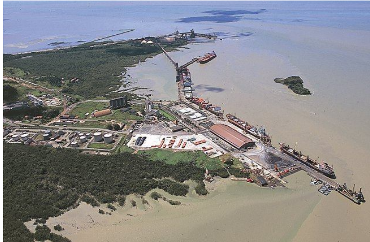
Figura 3: Vista aérea do Porto de Itaqui. Fonte: Ministério dos Transportes (2009).
