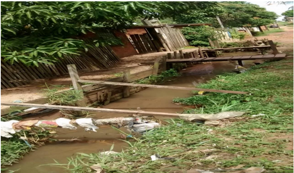
Figura 9 : Lixo e Esgoto acumulado no bairro do Tapanã
