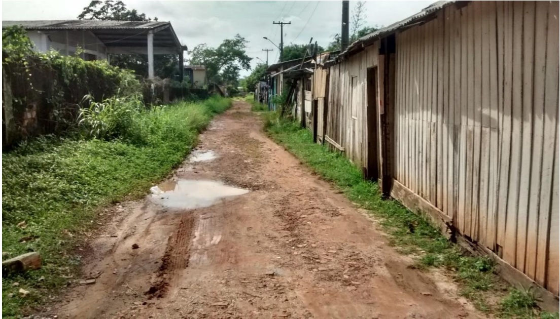
Figura 6: Travessa Uberaba sem asfaltamento no bairro do Tapanã
