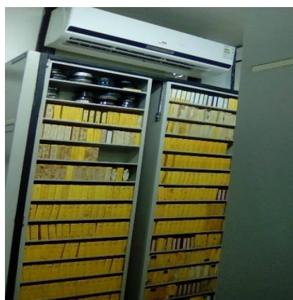
Figura 2- Armário e condicionamento
