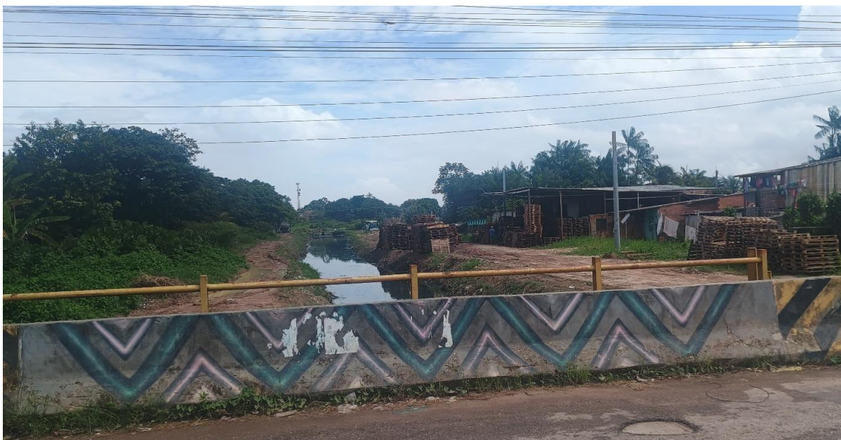
Figura 29 – Registro de impactos socioambientais (Construção próxima a drenagem)
