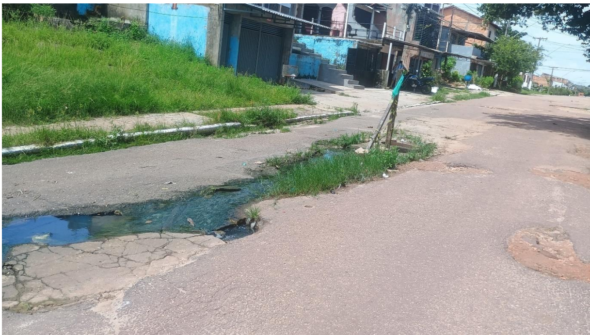
Figura 28 – Registro de impactos socioambientais (Erosão do Solo)
