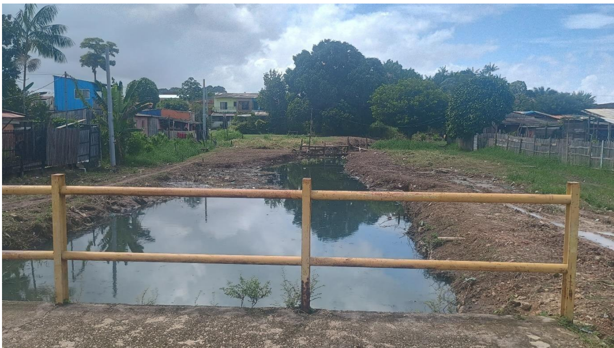
Figura 30 – Registro de impactos socioambientais (Drenagem)
