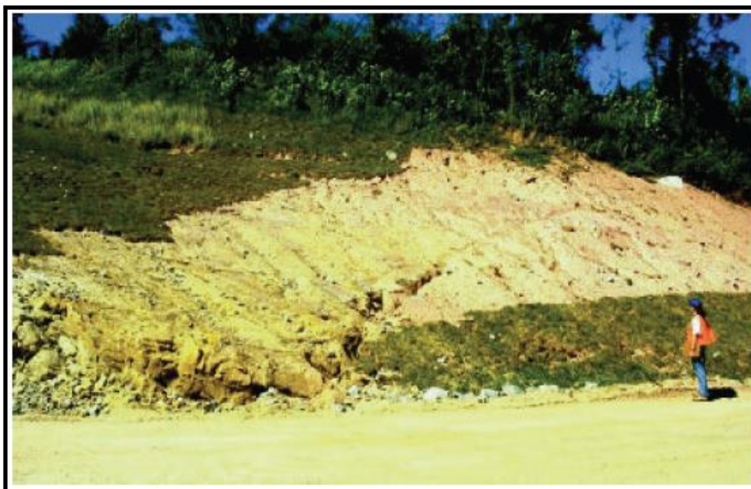
Figura 10: Revegetação em execução com placas de herbáceas (gramíneas) em talude de via de circulação interna (Itapeccerica da Serra-SP).
