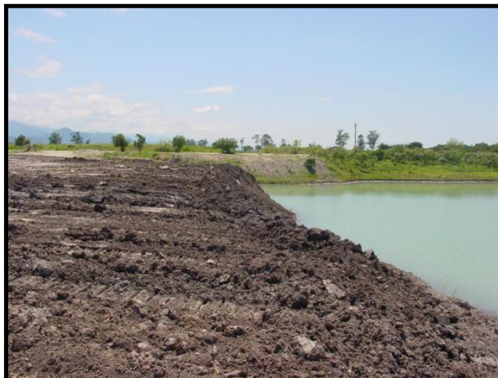
Figura 32: Talude marginal da cava sendo refeiçãoado. Fonte: Almeida 1 (2009).
