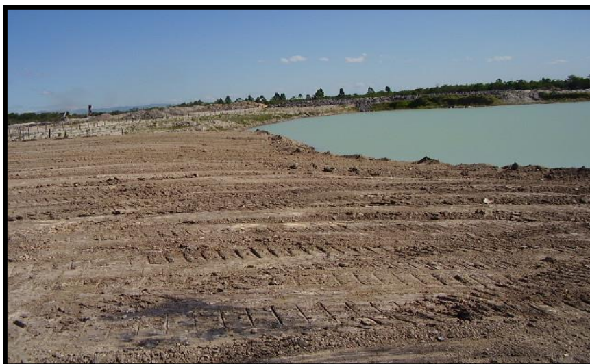
Figura 30: Aterro finalizado, pronto para receber o plantio. Fonte: Almeida 1 (2009).
