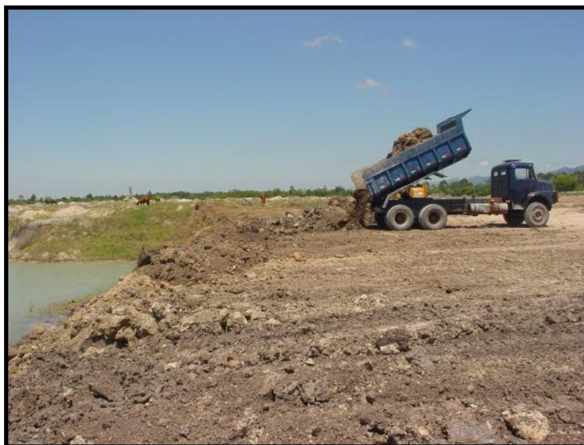
Figura 29: Caminhão despejando material de aterro utilizado no refeição da borda da cava. Fonte: Almeida 1 (2009).
