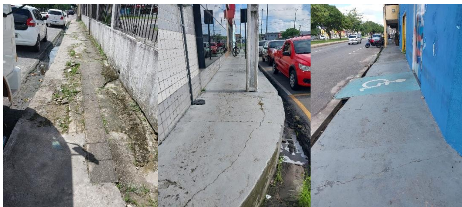
Figura 5 – Trechos T17 (manutenção: 2), T7 (manutenção: 4) e T15 (manutenção: 4)
