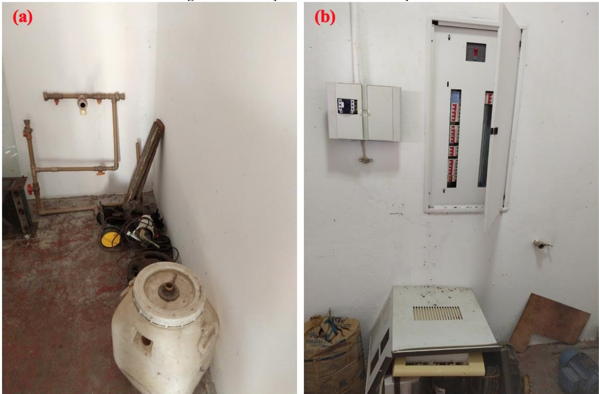
Figura 16. Condições da Sala de Subestação.
