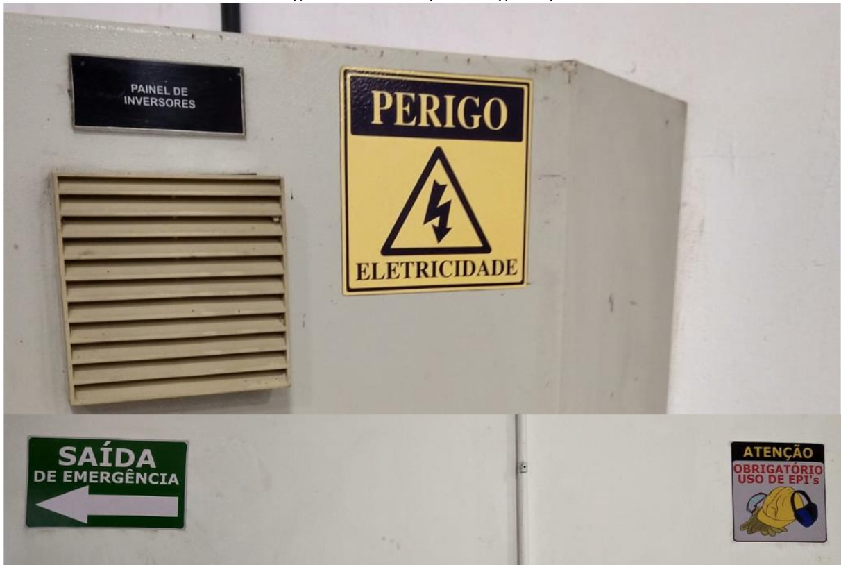
Figura 29. Sinalização de Segurança.
