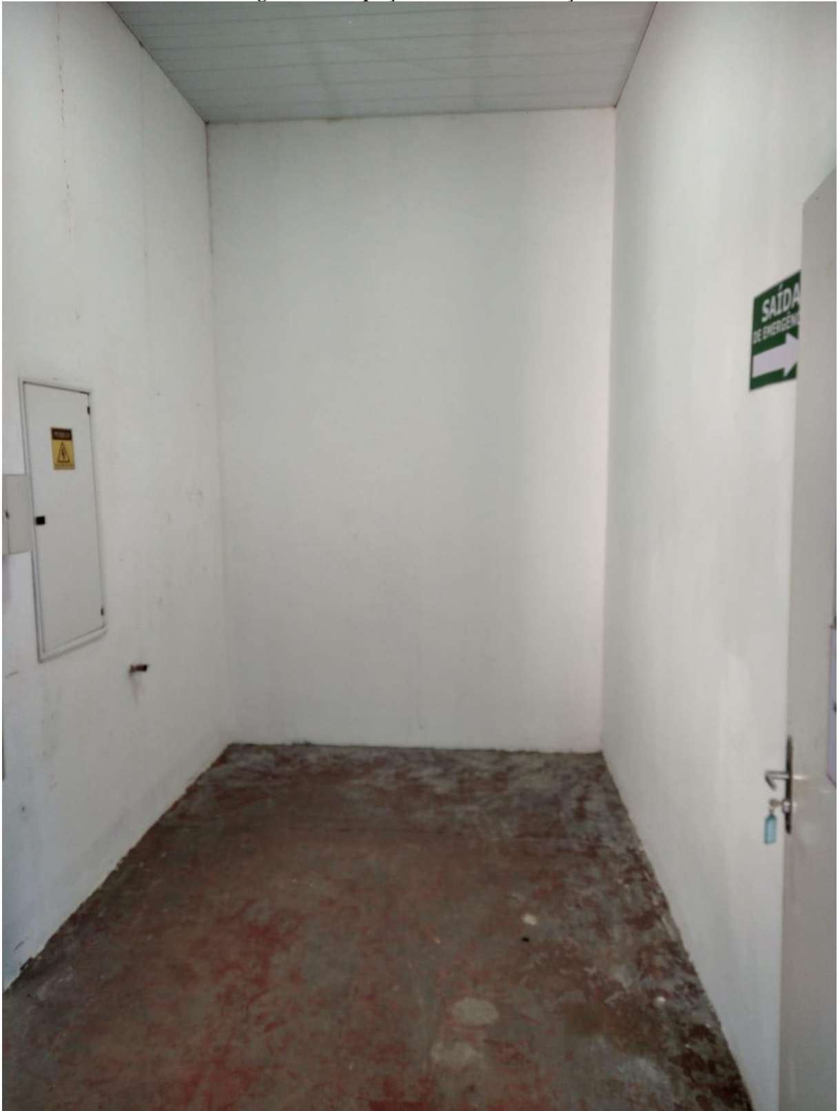
Figura 27. Adequação da Sala da Subestação.
