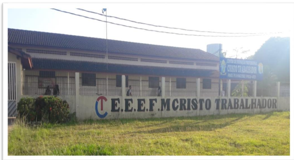
Fotografia 01 – Fachada da Escola Cristo Trabalhador
