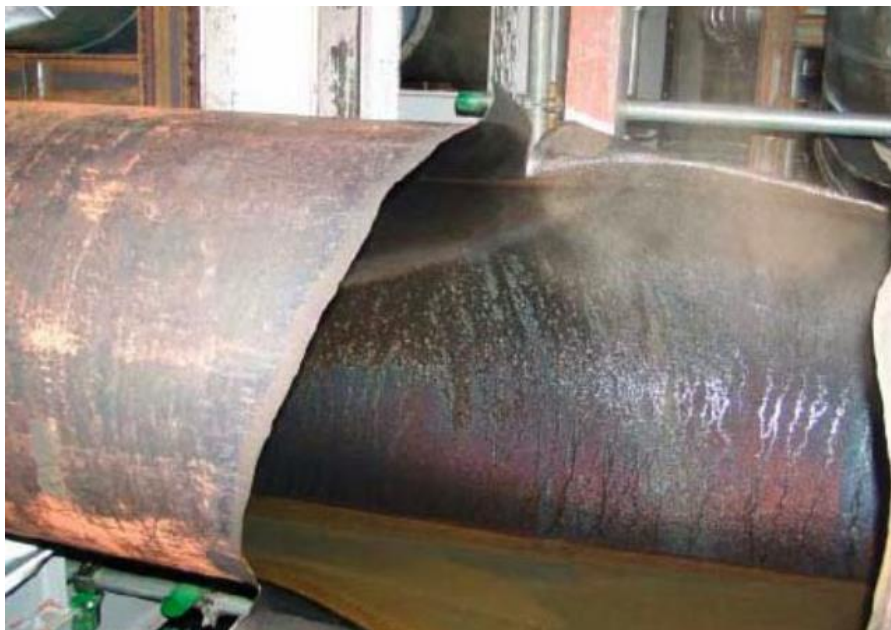
Figura 1. Tubulação do sistema de vapor rompida da Usina Nuclear de Mihama.
