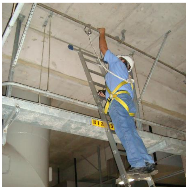
Figura 3.6. Inspeção realizada entre o corredor e os acumuladores. Fonte: Autoria nossa, 2015
