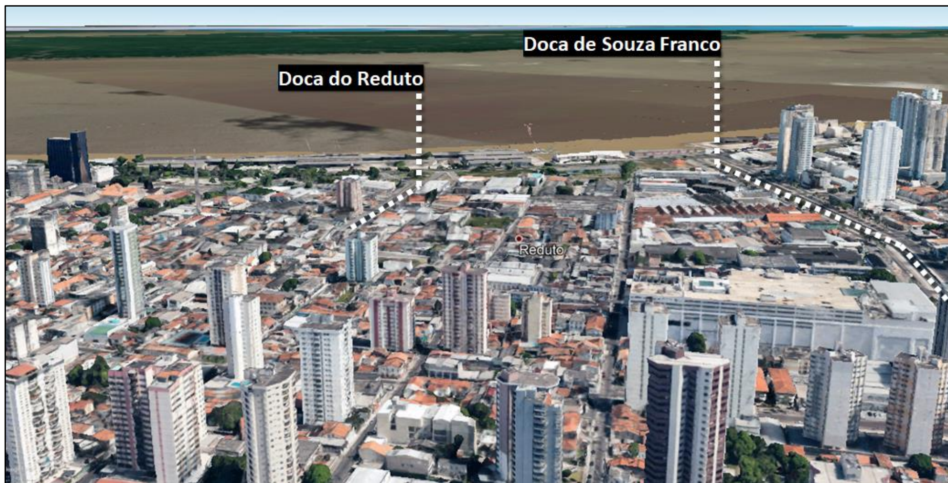
Figura 35 - Imagem aérea do bairro do Reduto. Destaque para a verticalização materializada no tecido do bairro. Ao fundo, a Baía do Guajará. Fonte: Google Earth, 2018. Elaboração: Davi Santos, 2019.
