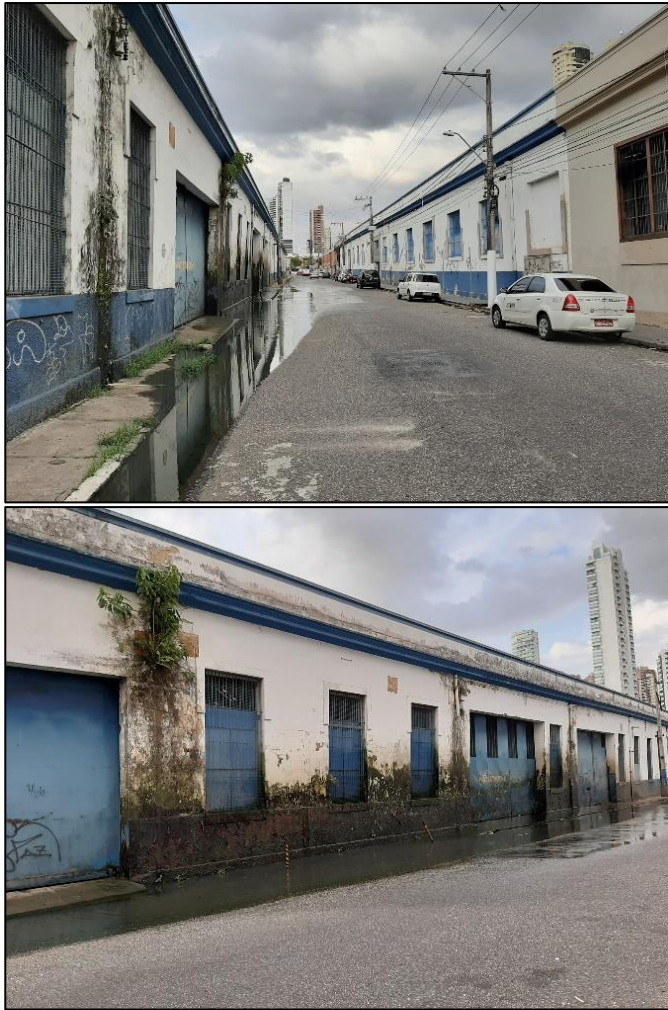
Figura 41 - Trecho alagado na Rua Gaspar Viana, entre a Tv. Quintino Bocaiúva e a Av. Visconde de Souza Franco. Ao analisar a deterioração da calçada e da parede da edificação, esta área encontra-se inundada continuamente por um tempo considerável, acusando patologias nas paredes. Fonte: Davi Santos.
