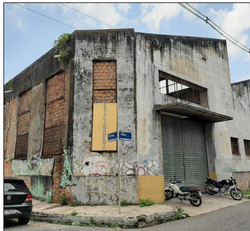
Figura 23 - Prédio utilizado como galpão de armazenamento e estacionamento, no cruzamento entre a Travessa Piedade e o Beco da Piedade, em estado de deterioração. Fonte: Davi Santos, 2019.
