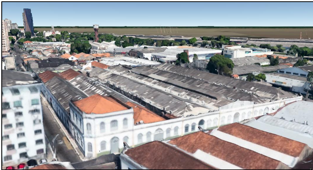
Figura 27 - projeção tridimensional da condição atual do prédio da antiga Fábrica Perseverança (mesmo ângulo da Figura X). Fonte: Google Maps, 2018.
