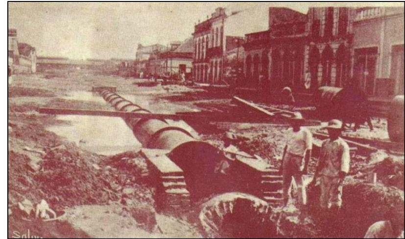
Figura 4 - Obras de ratificação do curso d'água e aterramento da foz da Doca do Reduto, entre 1900 e 1910, vista a partir da Rua 28 de Setembro em direção ao rio. Fonte: Blog da FAU, 2015.
