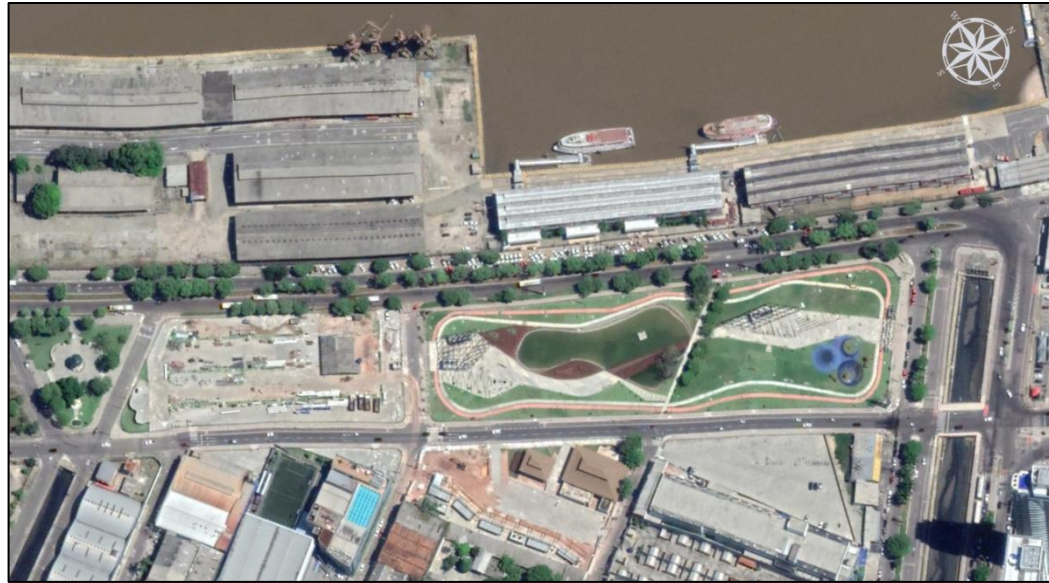
Figura 9 - Imagens de satélite do Parque Belém Porto Futuro, em fase final de obras. Fonte: Google Earth, 2019.
