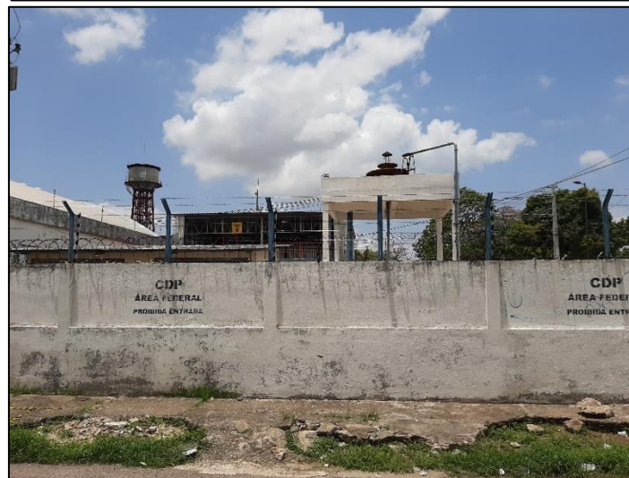
Figura 25 – Edificações com fachadas cegas em terrenos utilizados pela CDP. Fonte: Davi Santos, 2019.
