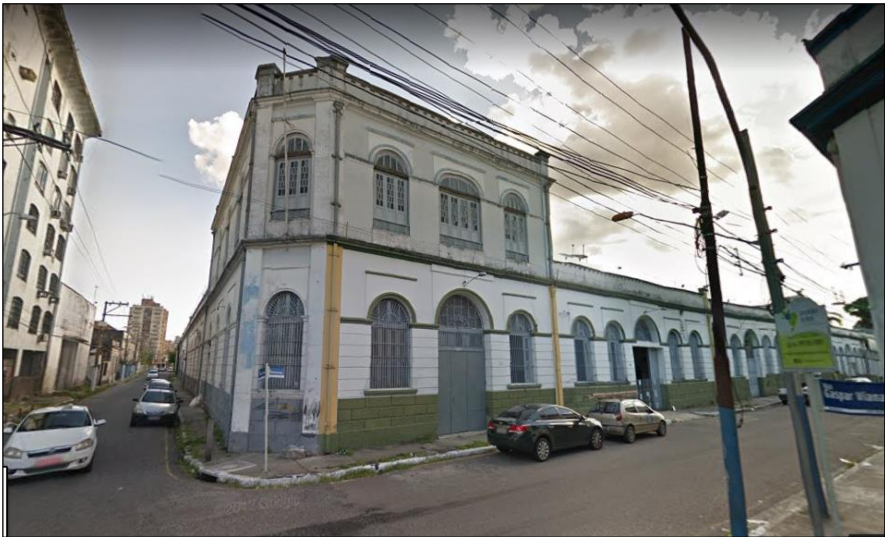
Figura 28 - prédio da extinta Fábrica Perseverança, atualmente ocupado parcialmente abrigando uma unidade da ESAMAZ, uma instituição privada de ensino superior. Fonte: Google Street View, 2017.
