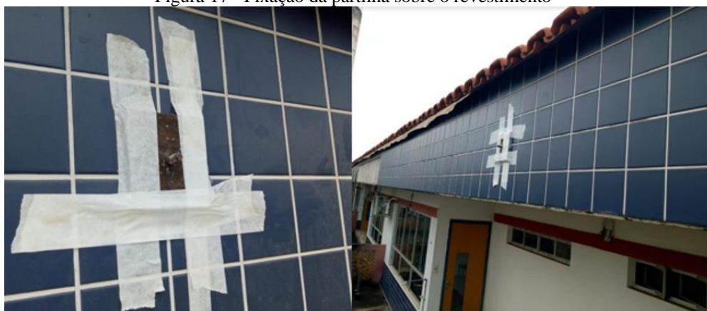
Figura 17 - Fixação da partilha sobre o revestimento
