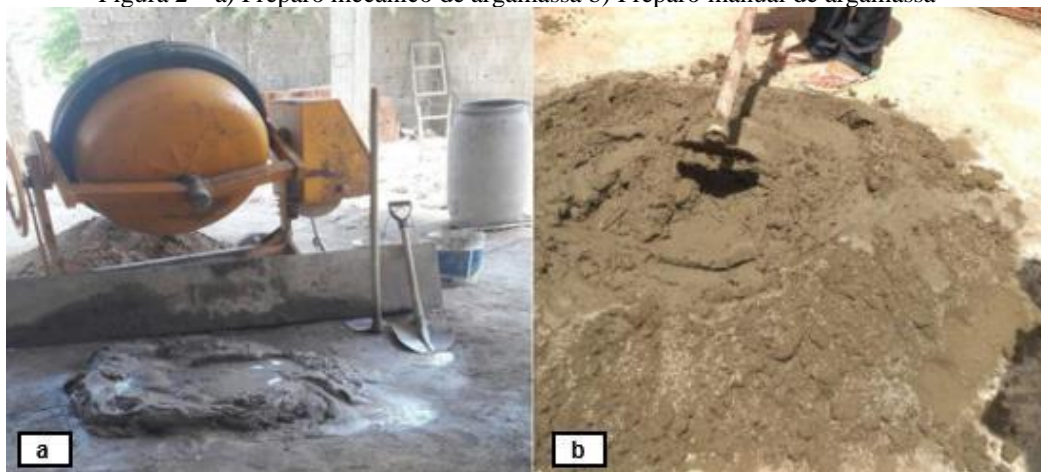
Figura 2 – a) Preparo mecânico de argamassa b) Preparo manual de argamassa
