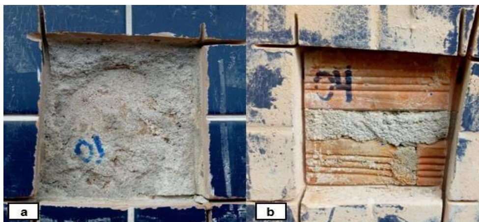
Figura 25 – a) Substrato de concreto armado b) Substrato de alvenaria cerâmica
