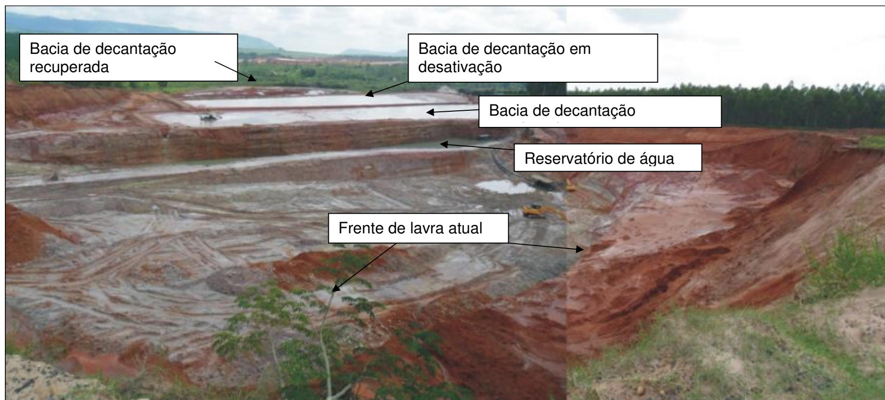
Foto 5.3.1-7 - Situação da área de lavra (fevereiro 2011)
