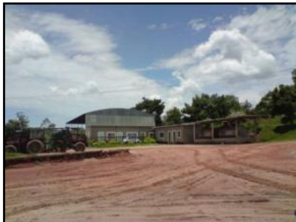
Foto 5.11-4 - Instalações da Realmix
