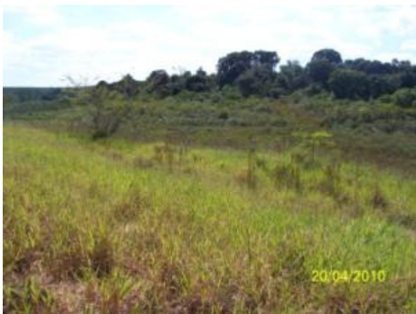
Foto 6-9 - Talude de bacia de decantação recuperado.
