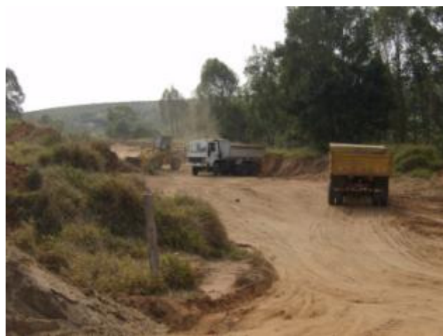
Foto 6-4 - Material retirado das leiras para promover a cobertura da bacia de decantação (junho 2005)
