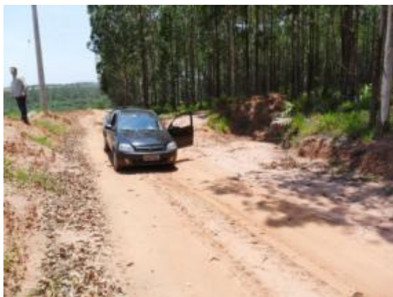
Foto 5.6-1 - Estrutura de contenção de água.
