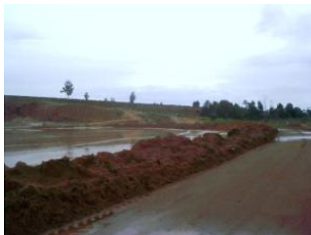
Foto 6-6 – Disposição de finos para aterramento da bacia (janeiro 2006).
