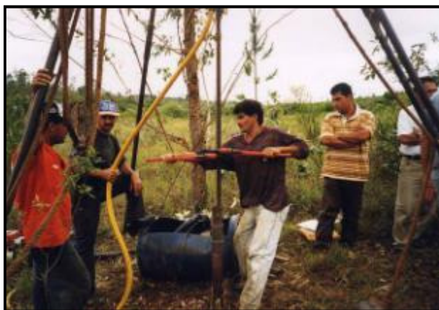
Foto 5.2-1 - Trabalhos de sondagem
