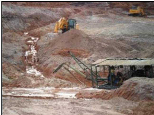
Foto 5.3.1-2 – Escavadeiras promovendo o desmonte, e polpa direcionada à primeira draga.
