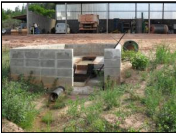
Foto 5.11-1 - Em primeiro plano, caixa separadora de óleo e água. Em segundo oficina da Realmix
