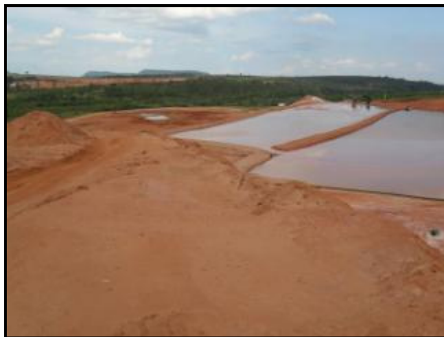
Foto 5.3.1-6 - Rejeito formando bacias de decantação.
