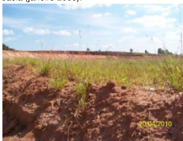
Foto 6-8 - Alteamento da bacia de decantação com material proveniente das leiras (abril 2010).
