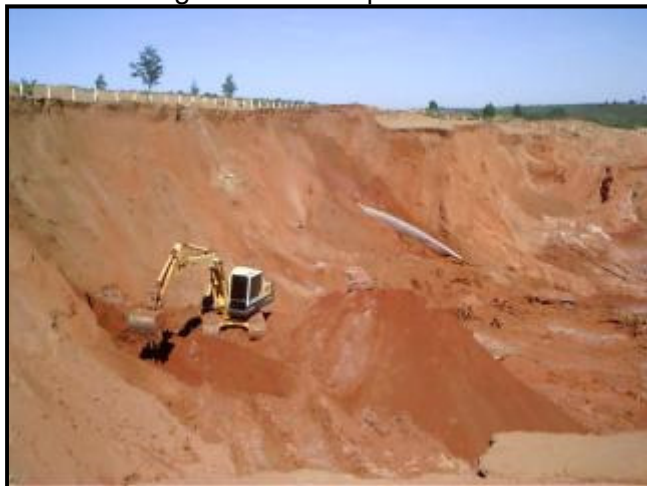
Foto 5.3.1-1 – Frente de lavra em desenvolvimento. Utilização de monitores para desmonte hidráulico
