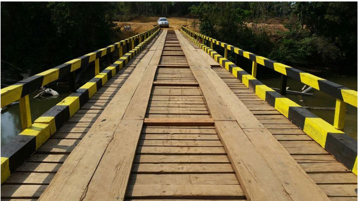
Figura 2 (depois). Ponte do rio Uruará do km 165 sul após ser construída. Foto obtida por via internet.
