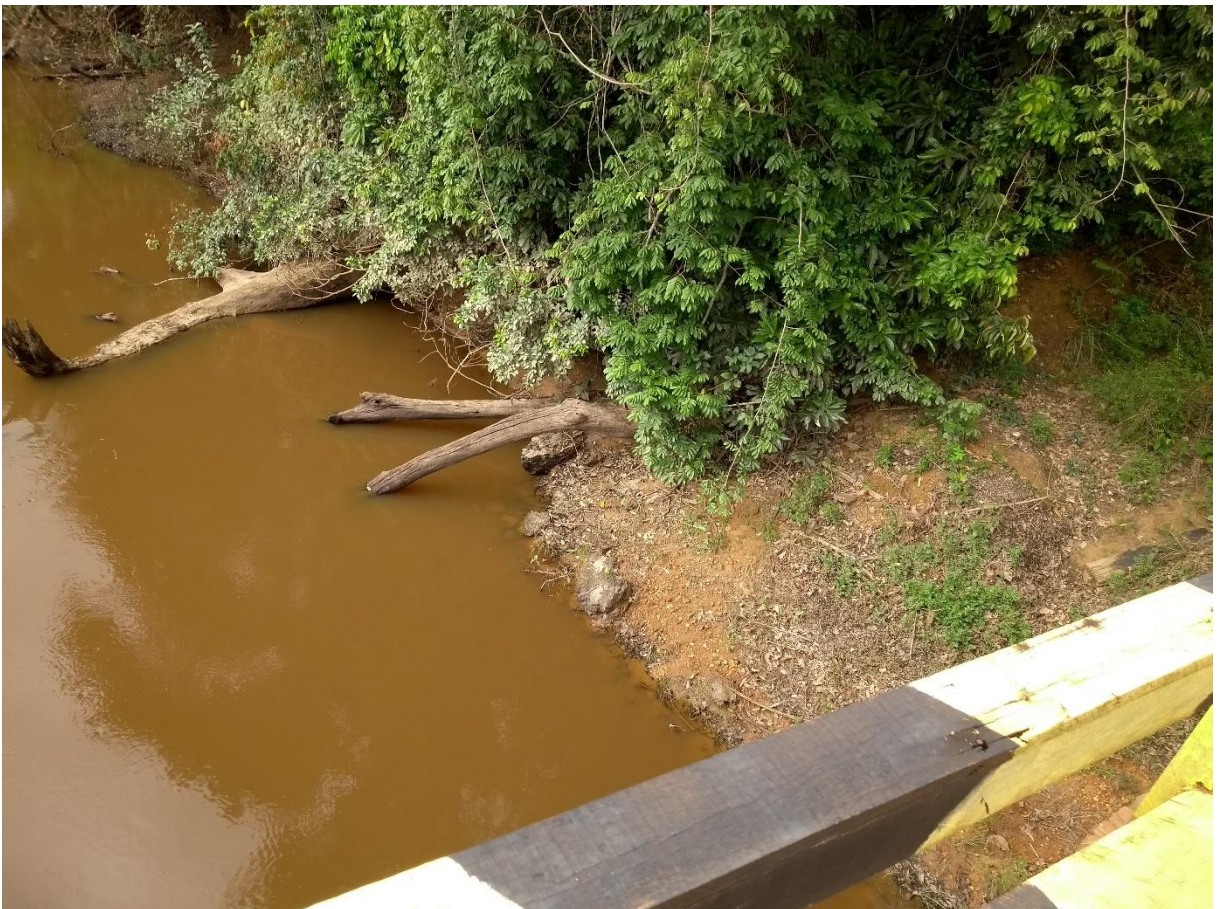
Figura 10 (depois). Leito do rio Uruará do km 165 sul. Foto de Eunice M. Lopes.
