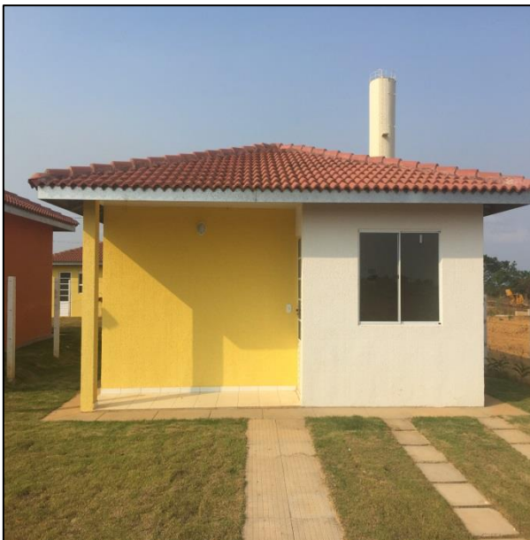
Fotografia 3.2 – Fachada da residência monitorada.
