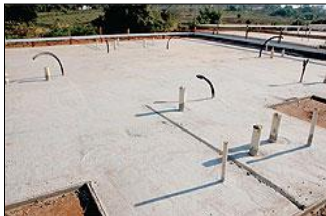
Fotografia 2.3 – Instalações hidrossanitárias e elétricas embutidas à fundação.
