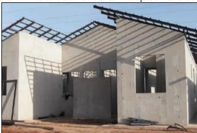
Fotografia 2.1 – Residência unifamiliar com vedações em concreto armado.
