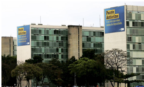
Imagem 1 - Propagandas nas fachadas na Esplanada dos Ministérios Fonte : Jorge William/ Agência O Globo
