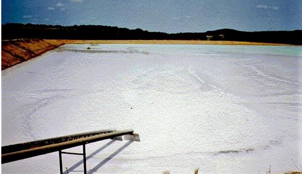
Figura 4- Lagoa de sedimentação
