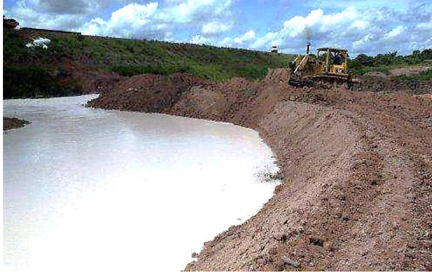
Figura 6- Máquina na lagoa de sedimentação onde o resíduo de caulim é depositado
