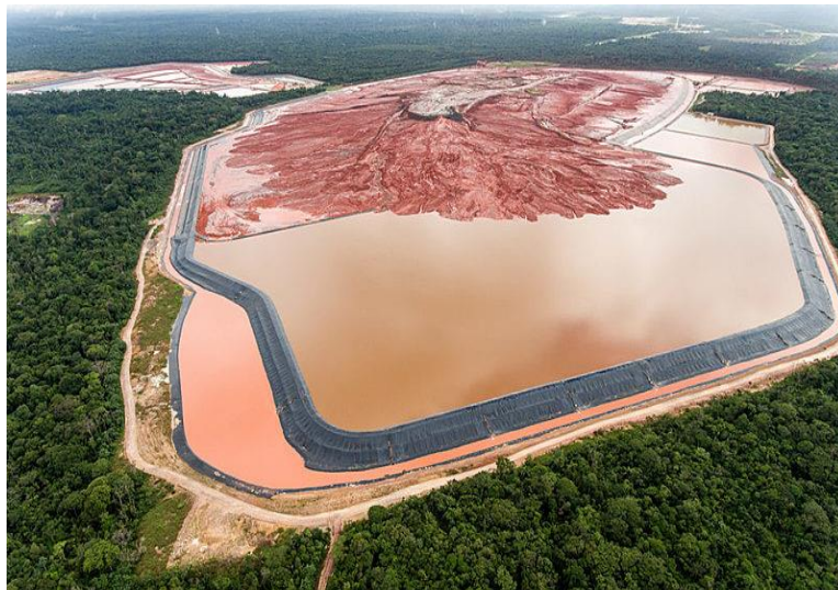
Figura 9 - Vazamento da bacia de rejeitos da mineradora Hydro Alunorte
