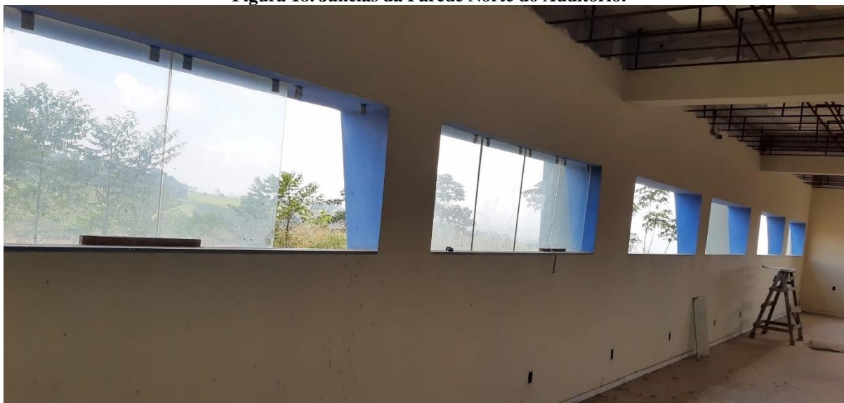
Figura 18. Janelas da Parede Norte do Auditório.
