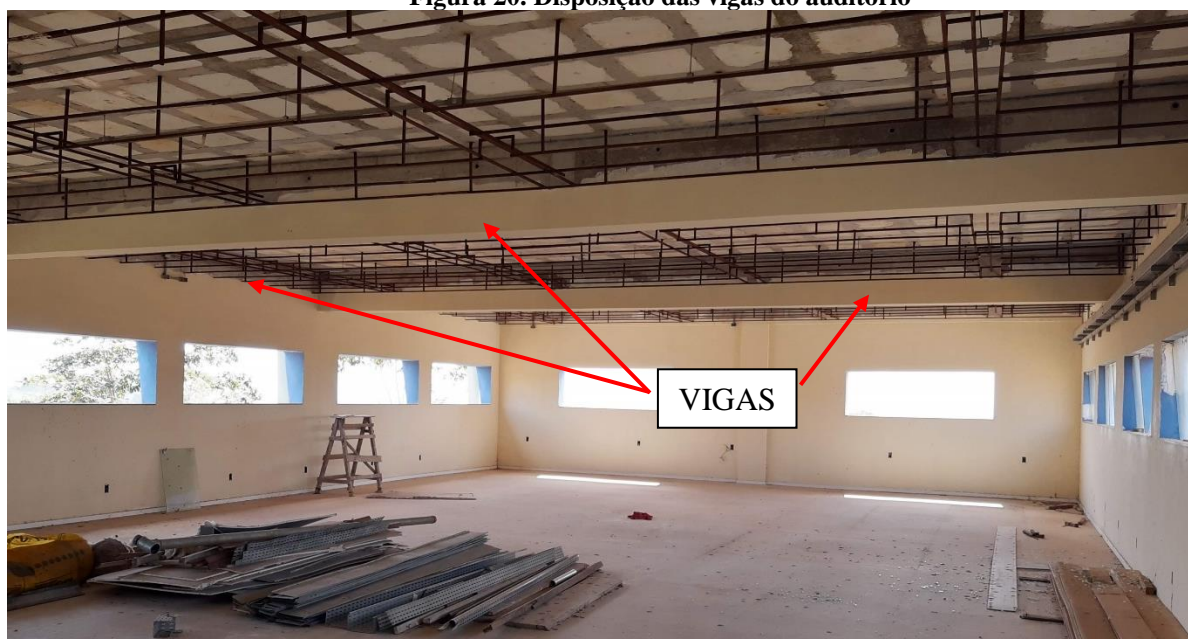
Figura 20. Disposição das vigas do auditório
