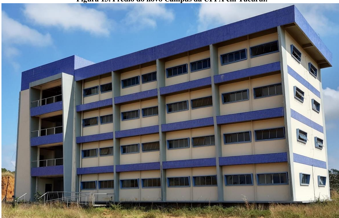
Figura 13. Prédio do novo Campus da UFPA em Tucuruí.
