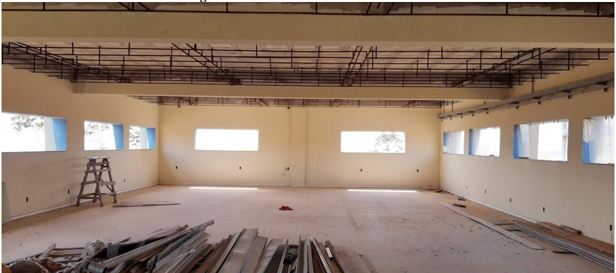
Figura 15. Novo auditório em fase de acabamento.
