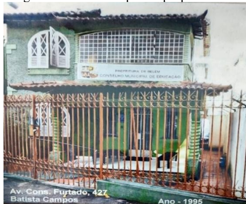
Imagem 1 — Primeiro prédio próprio do CME
