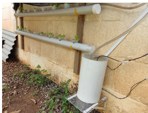
(b) Cisterna completa
