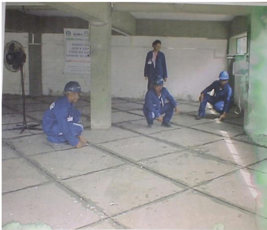
Foto 2 - Aplicação de piso Korodur. Fotógrafo Pina, 2004.
