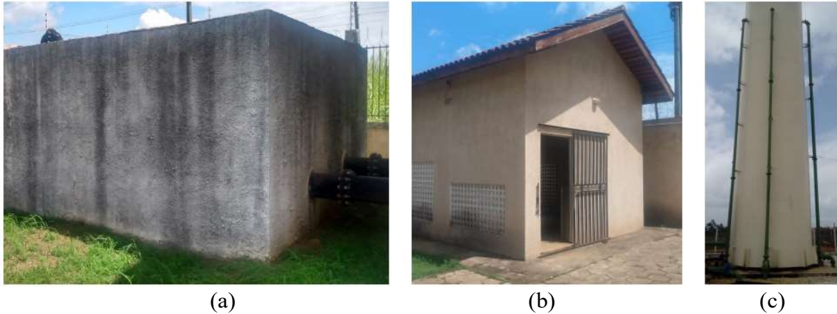
Figura 28 - (a) Parte superior do Reservatório Enterrado. (b) Estação Elevatória de Água. (c) Reservatório Elevado.
