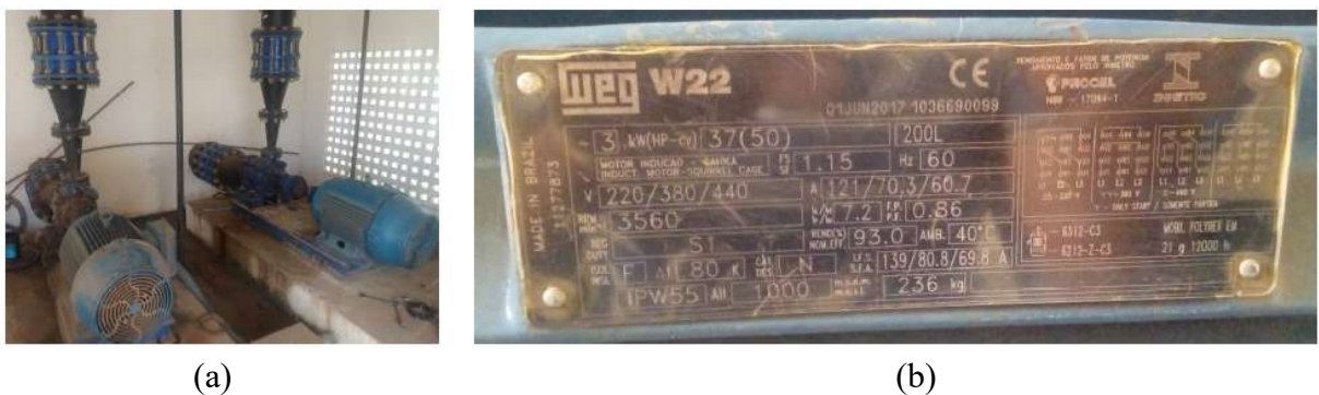
Figura 29 - (a) Os dois conjuntos motobombas; (b) Placa de dados dos motores.
