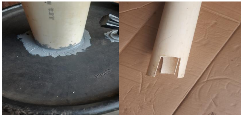
Figura 13 - Vedação da tubulação central
