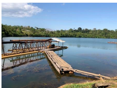
Figura 5 – Ponto de captação
