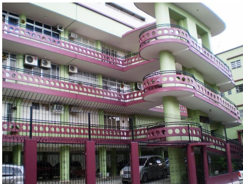
Figura 18 – Fachada do Edifício Dom Carlos
