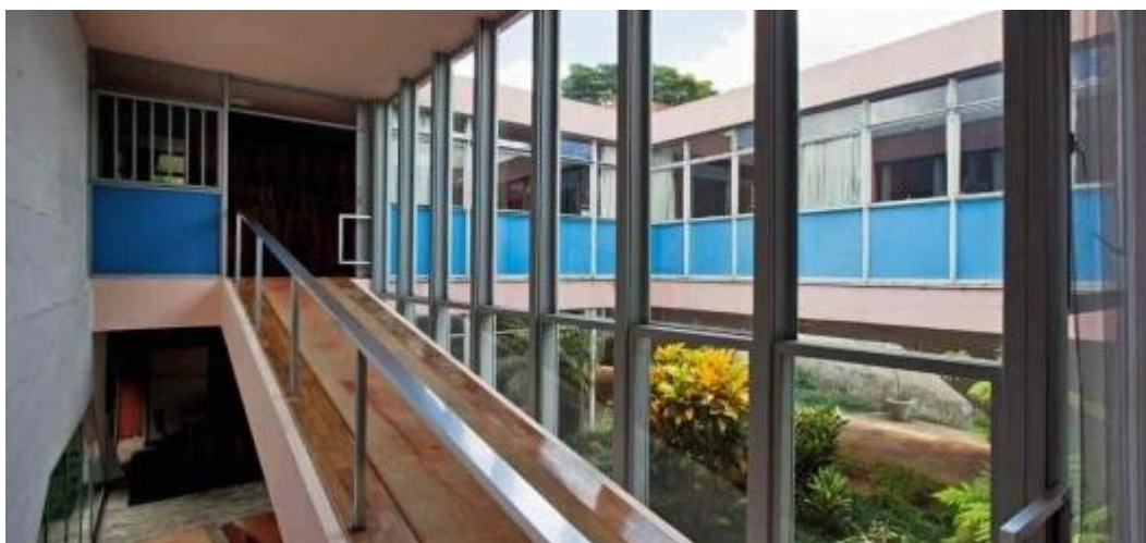
Figura 12 – Rampas e pátio da Casa Mario Taques Bitencourt II, de Vilanova Artigas, 1959
