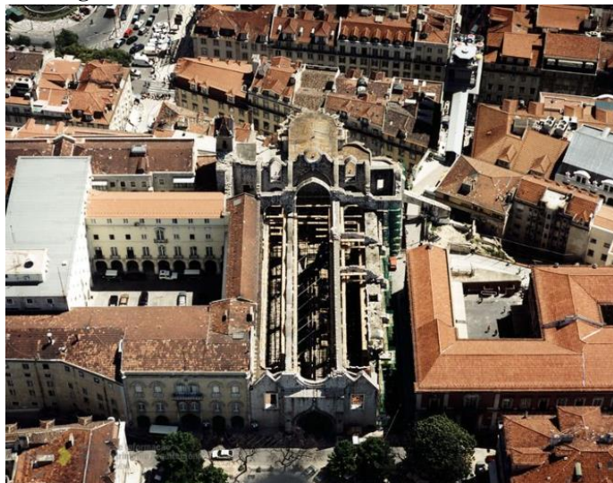
Figura 15: Vista aérea do Convento do Carmo, 1996.
