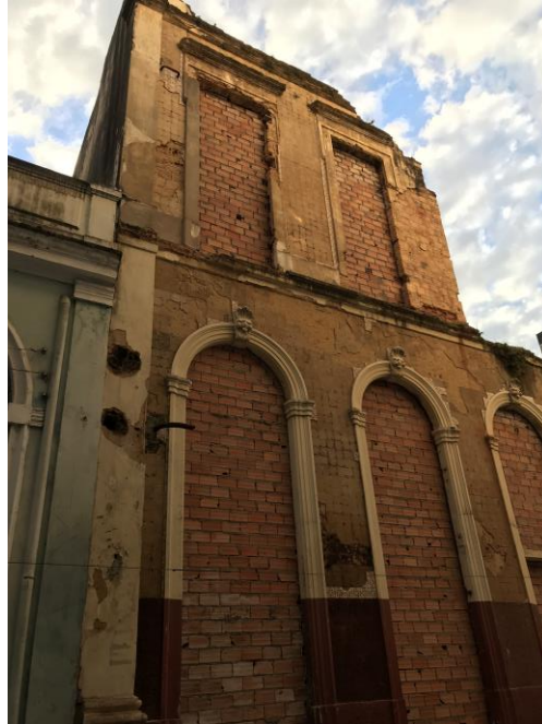
Figura 52: Parte da fachada remanescente da Casa Carvalhaes, pela Trav. Leão XIII.
