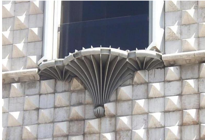
Figura 13: Detalhe das novas janelas, na parte superior.
