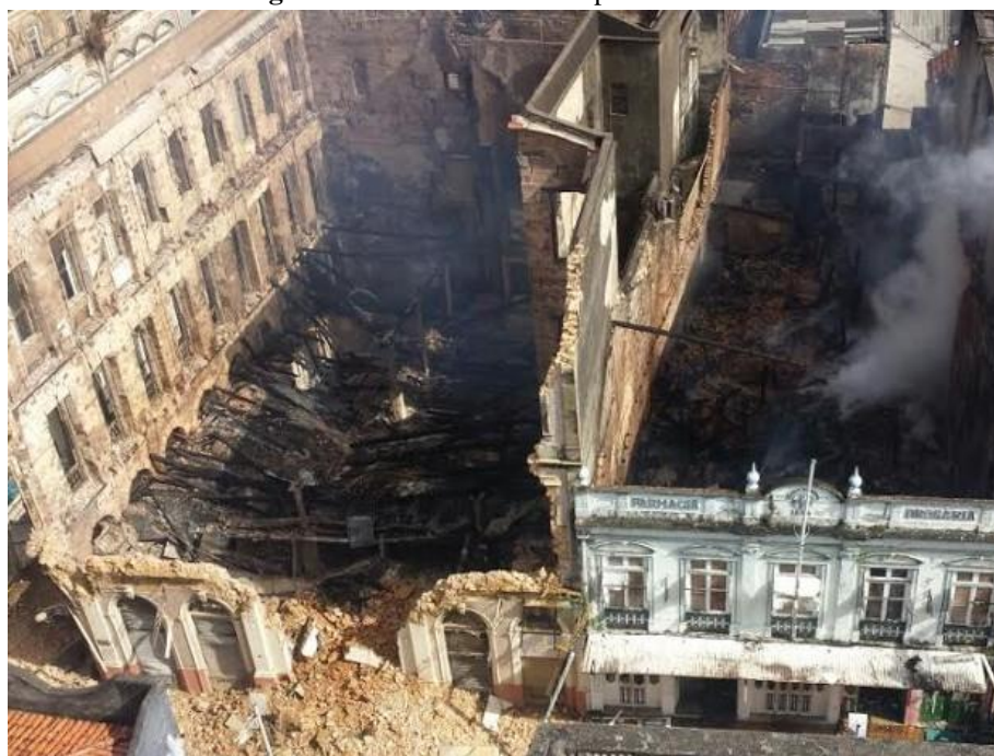
Figura 40: Casa Carvalhaes após o incêndio.
