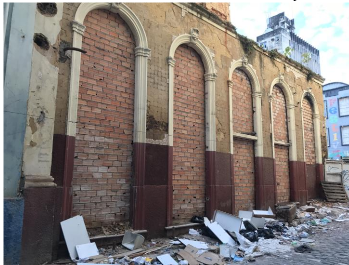
Figura 51: Parte da fachada remanescente da Casa Carvalhaes, pela Trav. Leão XIII.
