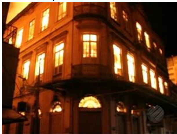
Figura 39: Fachada de esquina da Casa Carvalhaes, com interior em chamas.
