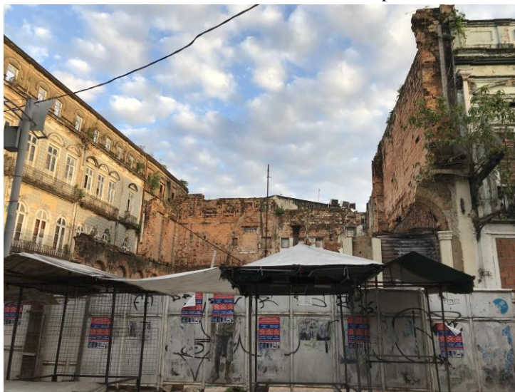
Figura 50: Fachada remanescente da Casa Carvalhaes, pela Rua Santo Antônio.
