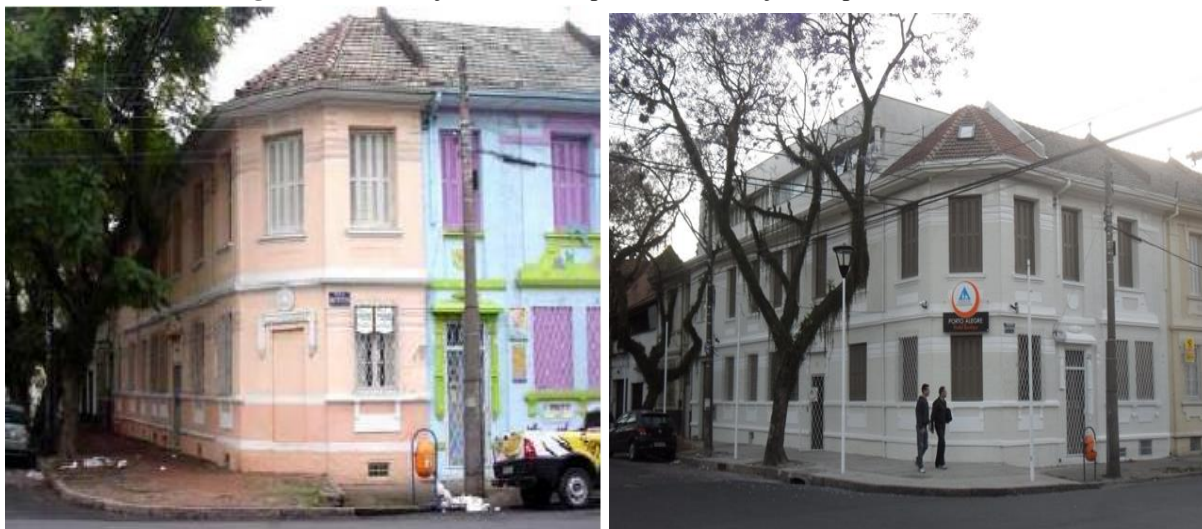
Figura 25: Edificações antes e depois da intervenção, respectivamente.
