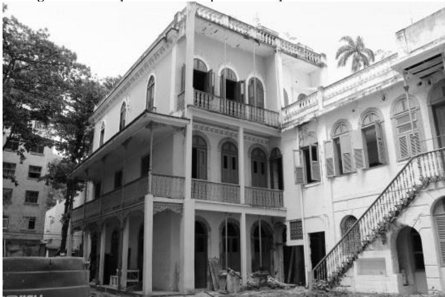
Figura 22: Situação de abandono que a edificação se encontrava em 2013.
