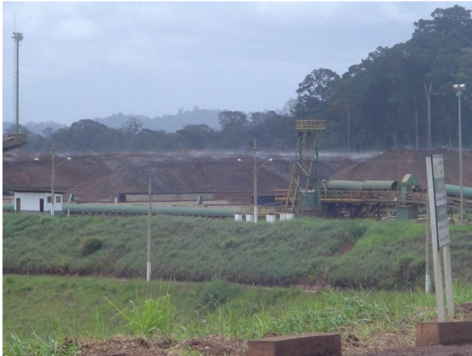
Figura 1 – Bacia de Rejeito da empresa MPBA, contendo o minério que passou pelo processo de neutralização.
