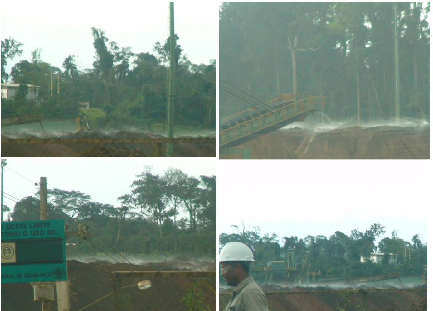
Figura 8 - Aspectos de emissão de gases para a atmosfera, nas bacias de rejeito da empresa MPBA, possivelmente ácido cianídrico provindo do beneficiamento de ouro.
