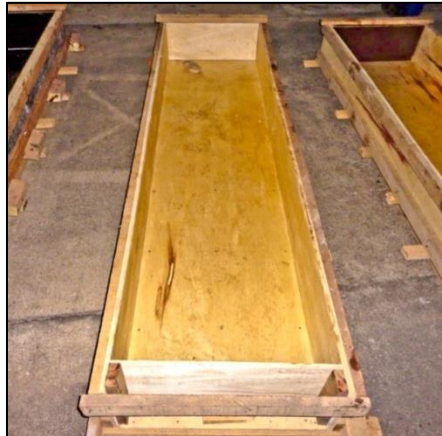
Figura 3.23-Formas utilizadas na confecção das vigas.
