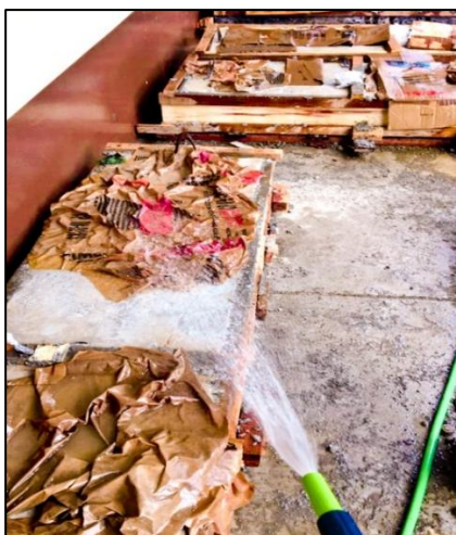
Figura 3.26-Cura das vigas.
