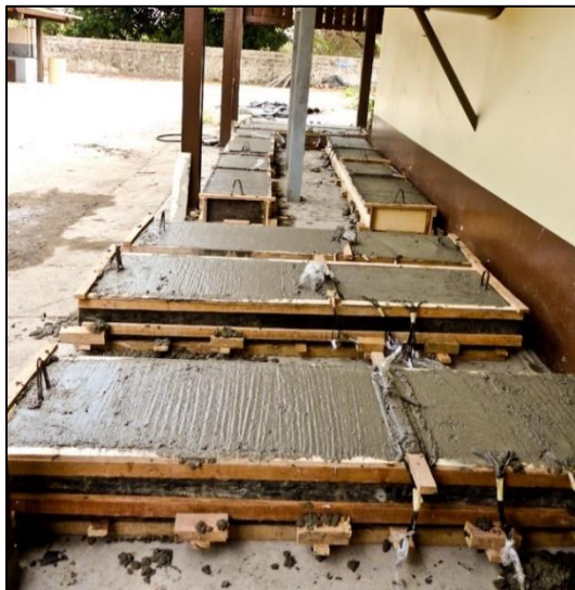
Figura 3.15- Vigas após a concretagem.
