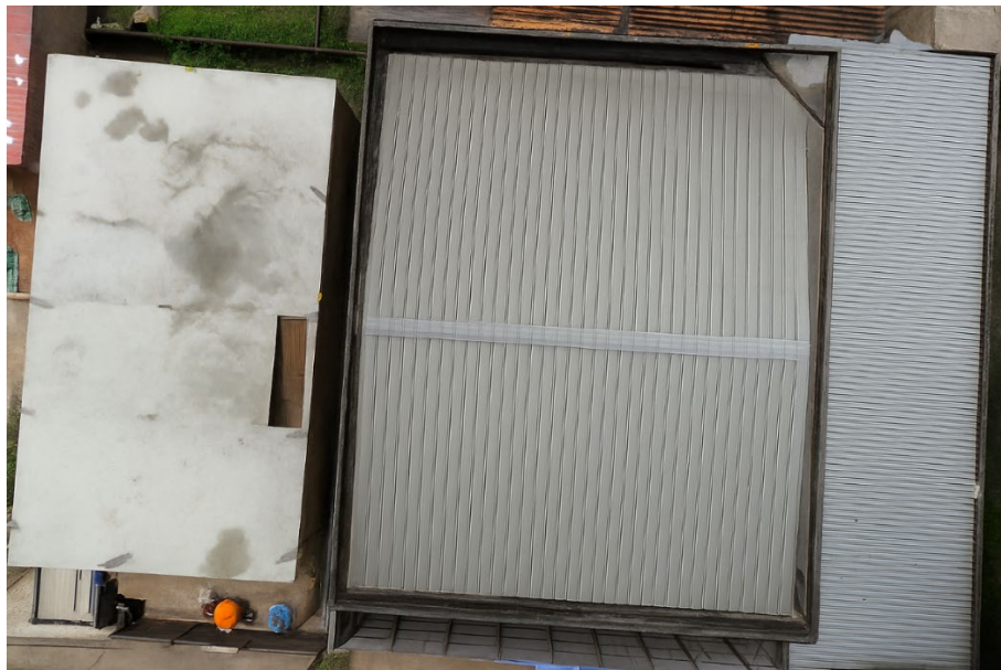
Figura 19 – Imagem aérea do telhado do local de instalação.
