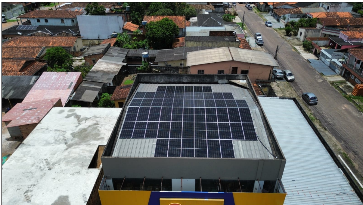
Figura 24 – Módulos instalados sobre o telhado da edificação.
