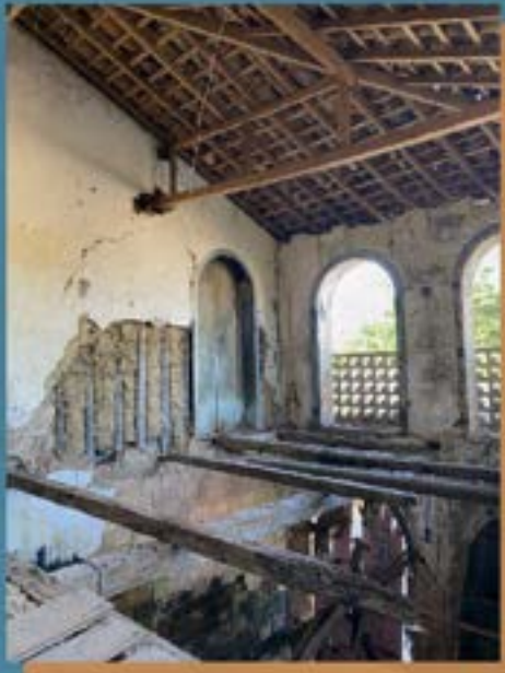
Figura 16 – Vedação feita com taipa de mão em uma das paredes. Fonte: Autora (2023).
