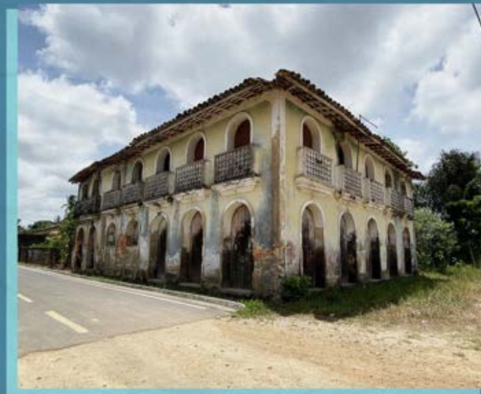
Figura 13 – Fachadas do edifício histórico objeto de estudo do presente trabalho.
