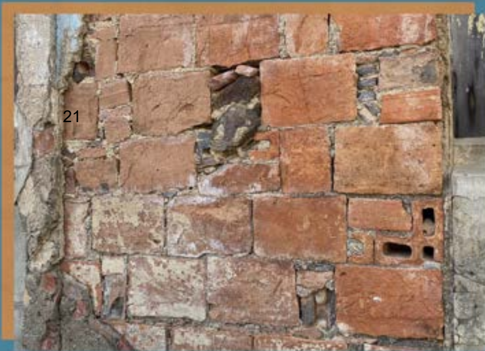
Figura 15 – Estrutura interna da fachada da edificação. Fonte: Autora (2023).
