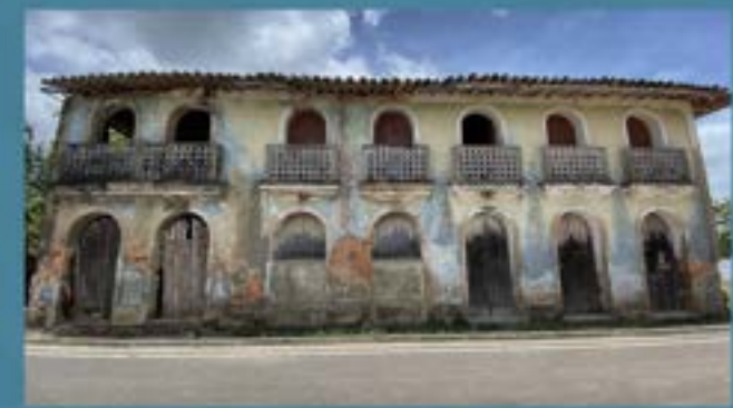
Figura 18 – Fachada ao nordeste, voltada para a Rua Raimundo Carrera. Fonte: Autora (2023).
