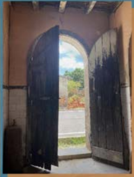
Figura 17 – Exemplo de esquadria do pavimento térreo. Fonte: Autora (2023).
