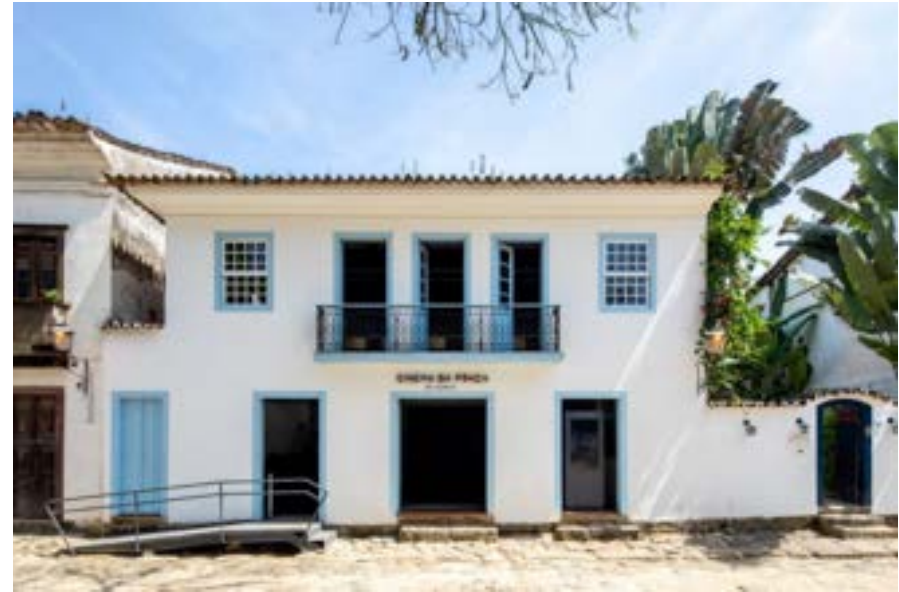
Figura 09 – Fachada do Cinema da Praça. Fonte: ArchDaily (2023).
