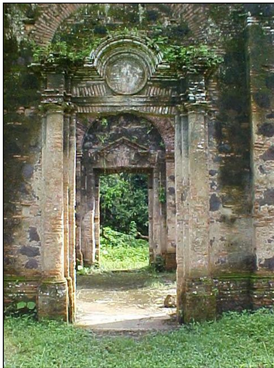
FIGURA 3. Elementos decorativos, em frisos e medalhão na entrada principal da Capela do Engenho Murutucu.
