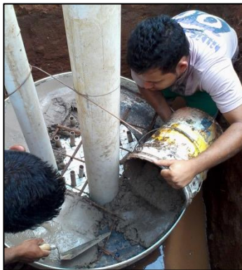
Figura 47 – Lançamento do concreto.
