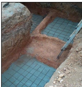
Figura 35 – Preparo de radier em diferentes cotas.
