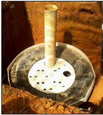
Figura 45 – Base para o concreto com furos.
