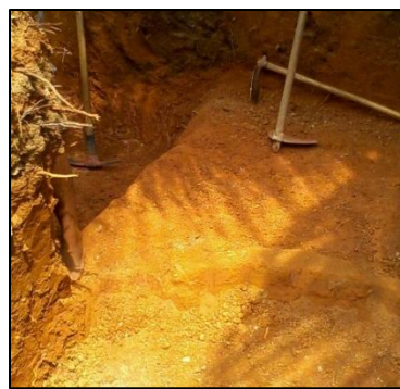
Figura 36 – Escavação das cotas para as unidades do sistema.
