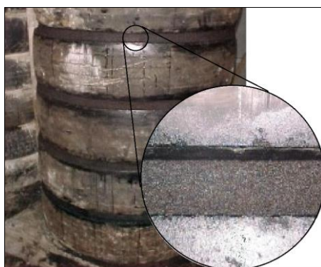
Figura 20 – Uso da massa asfáltica para aderência dos pneus. Fonte: Adaptado de BARRETO, 2006.
