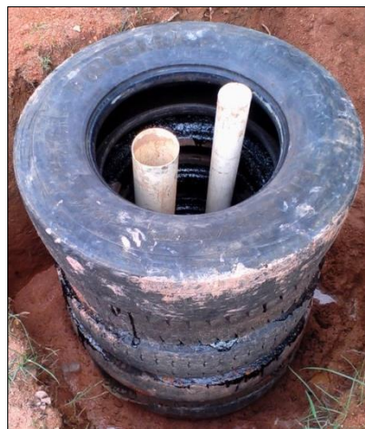
Figura 49 – Disposição dos pneumáticos sobre o fundo falso.
