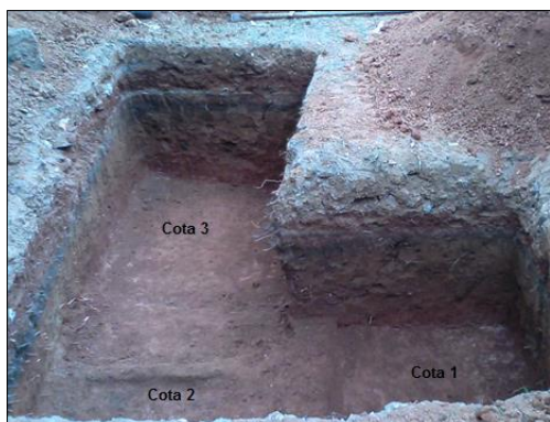
Figura 33 – Cava preparada para implantação do sistema.
