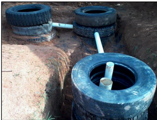
Figura 55 – Disposição das unidades com as tubulações
