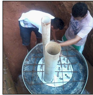
Figura 46 – Colocação da armadura.
