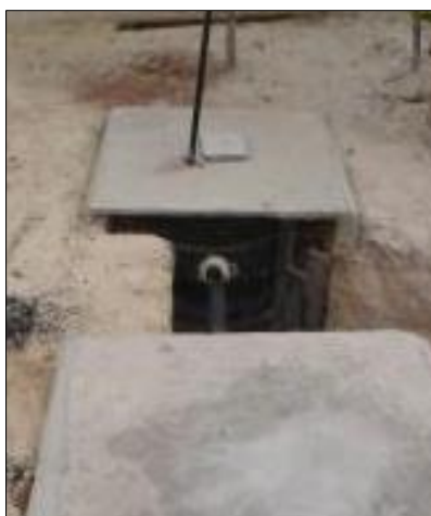
Figura 15 – Tanque séptico de pneus inservíveis. Fonte: BARRETO, 2006.
