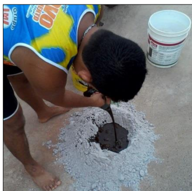
Figura 39 – Preparo da massa asfáltica.
