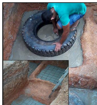
Figura 38 – Fixação do pneumático no radier sobre a armadura.
