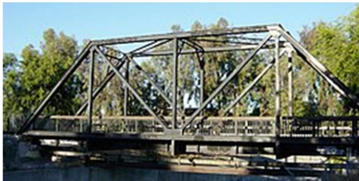
Figura 1 – Imagem de uma ponte com estrutura em treliça.
