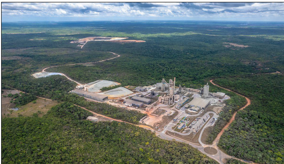
Figura 2: Imagem aérea da fábrica da Votorantim Cimentos em Primavera, no Pará. Foto: Jonne Roriz/ Nosso Impacto ( https://nossoimpacto.com.br/historias/caroco-de-acai-vira-combustivel-em-fabrica-de-cimento-da-votorantim-cimentos/ ).
