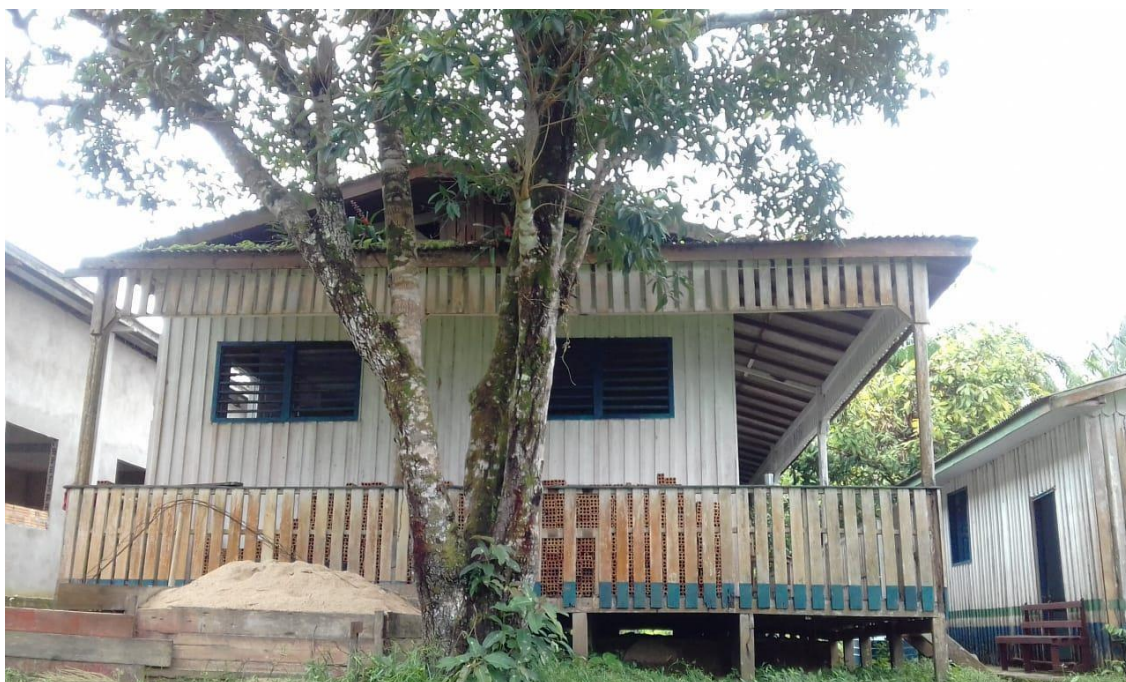
Figura 12: Fachada da Escola Fazenda Laranjal.
