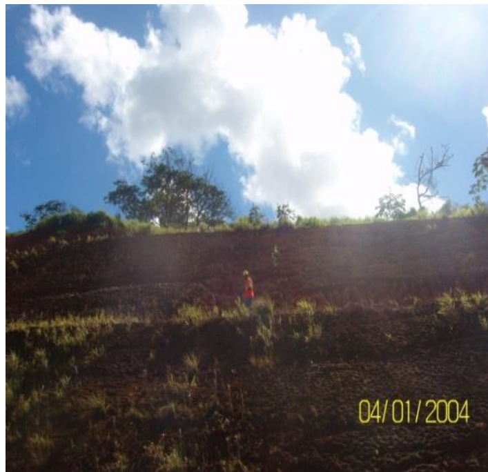
Figura 12 – trecho da Av Luis Eduardo Magalhães com cobertura de vetiver. Fonte: www.cprm.gov.br
