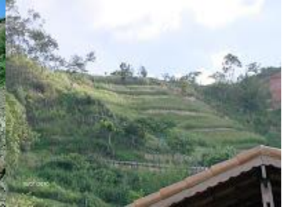
Fig 11 – mesma área recuperada e estabilizada com capim vetiver. Ano: 2010. Fonte: www.vetiver.org .
