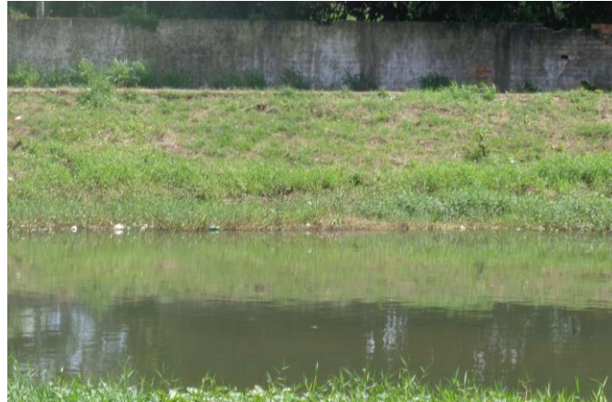
Fig 02 - Canal da Sacramento revestido com capim quicuiu.
