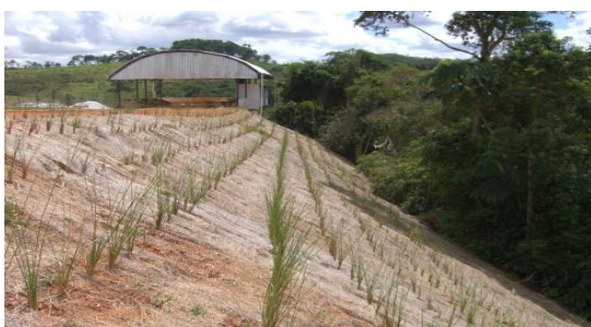
Fig 06 - formação de barreiras vivas de capim Vetiver transversalmente à declividade do talude. Fonte: www.vetiver.org .
