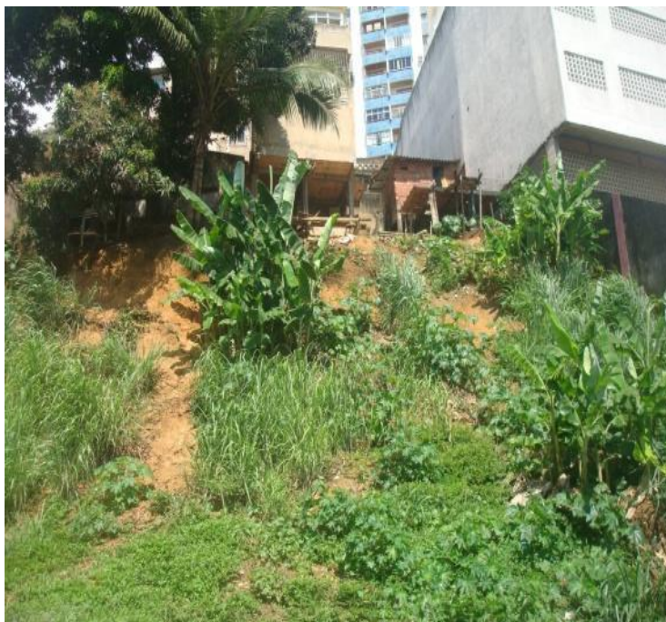
Figura 13 – trecho de Vale dos Barris com cobertura de vetiver. Fonte: www.cprm.gov.br .
